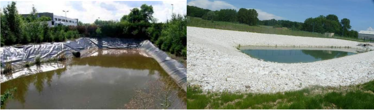
Exemples de bassins de récupération des eaux pluviales inadaptés au développement de la faune
