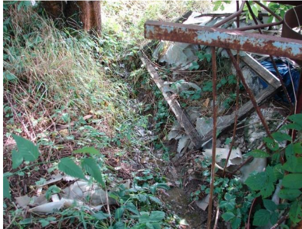
Fossé actuel régulièrement à sec, dégradé et obstrué par des dépôts divers.
