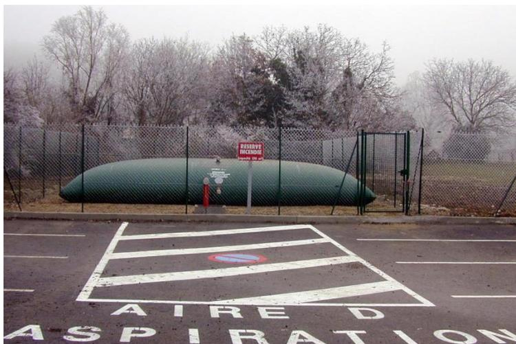
*Photo 2 : Exemple de réserve incendie hors sol souple et ses équipements annexes*
