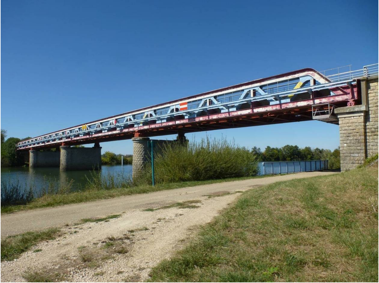
Photo 01 : Vue du l'élévation aval de l'ouvrage concerné
