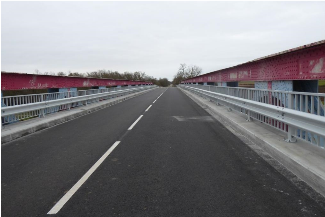
Photo 02 : Vue du dessus de l'ouvrage
