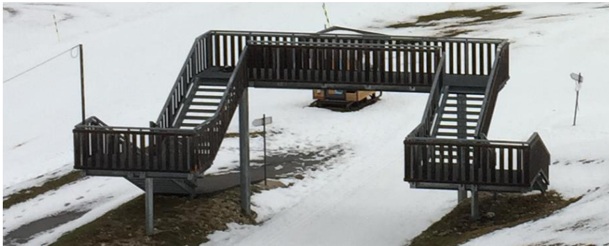
Passerelle piétonne existante
