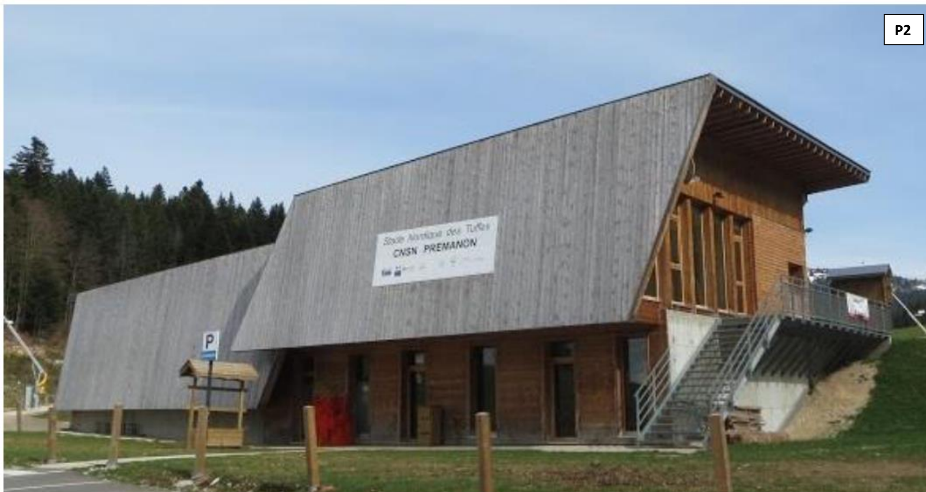
Photographie 2 : bâtiment d'accueil du stade des Tuffes (été 2016)
