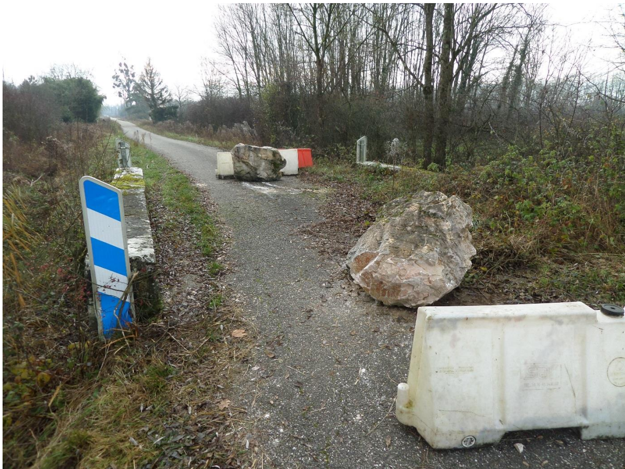
Vue générale de la chaussée sur l'ouvrage
