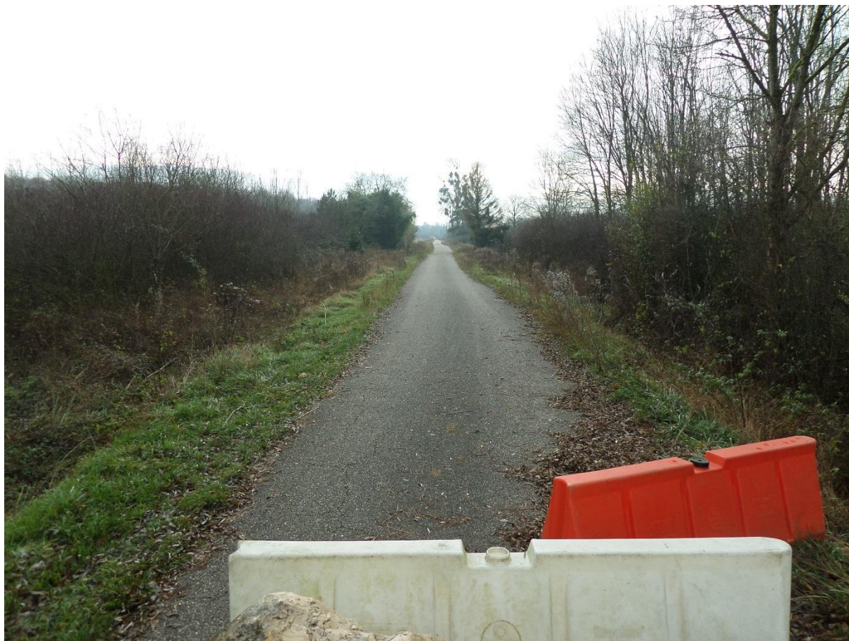
Vue générale côté RG en direction de « Le Gravier »
