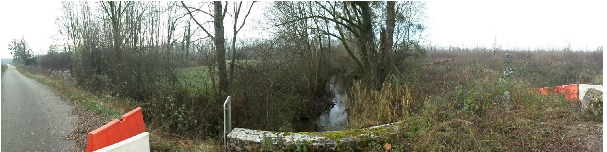
Vue d'ensemble côté aval
