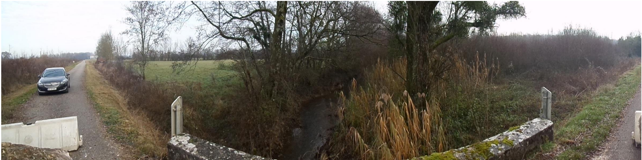
Vue d'ensemble côté amont
