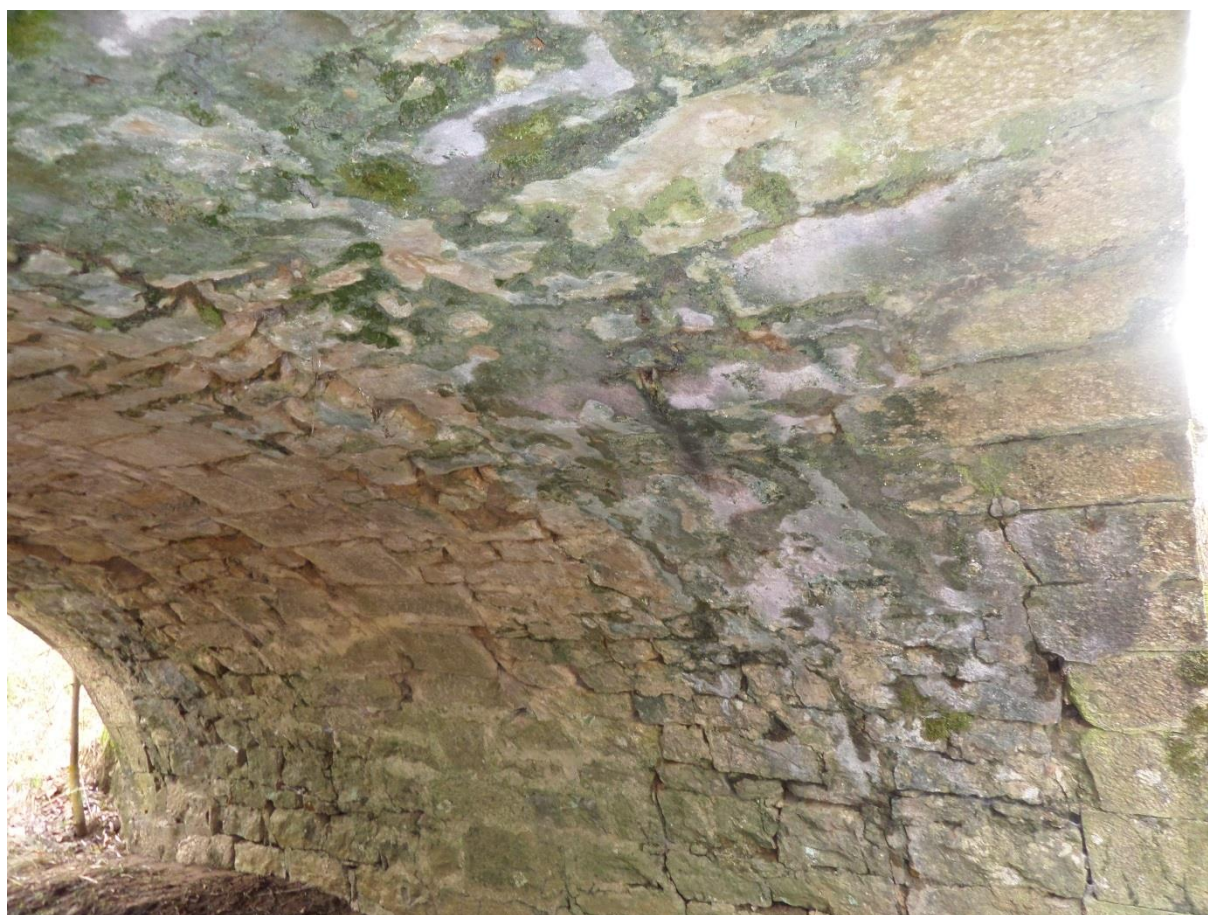
Vue générale de la voûte côté RD depuis l'amont
