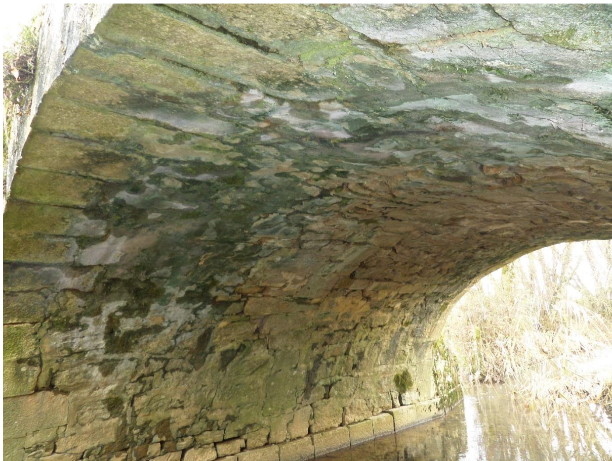
Vue générale de la voûte côté RG depuis l'amont
