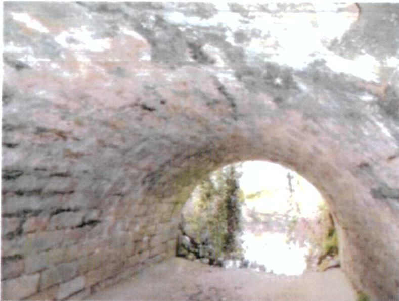
vue générale de la voûte depuis l'amont
