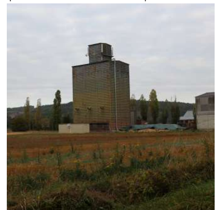
Tentative d'un travail colorimétrique sur un silo à grain / Bonne intégration d'une antenne relais
