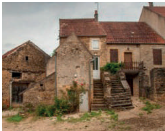
Maison de vigneron avec logis surélevé et entrée de cave sous escalier.
