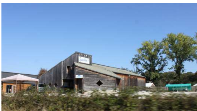
Enseigne en rupture avec le bardage (couleur-design)
