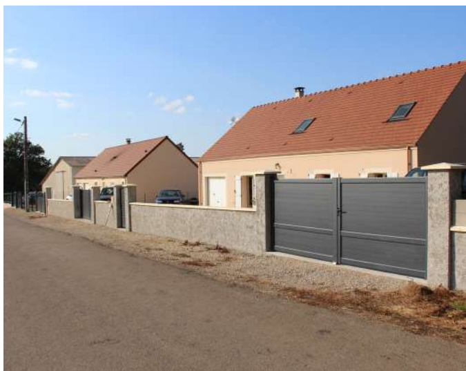
Maison d'habitation individuelle à Usy.
