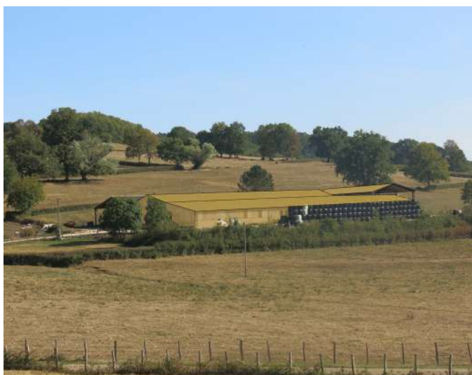
Bâtiments d'élevage et stockage isolés, sur la commune de Saint-Père.
