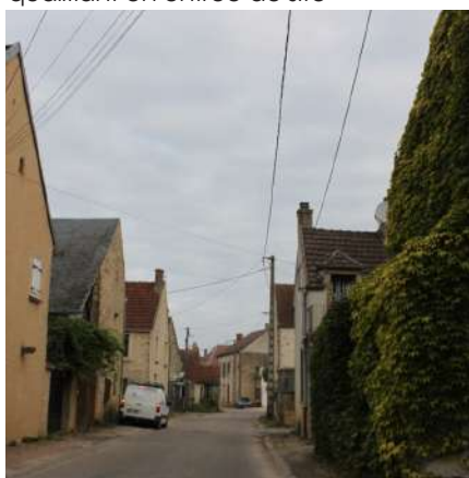
Les nombreux réseaux aériens détériorent la qualité de la rue
