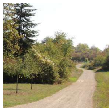
Chemin de champ en concassé calcaire à Givry
