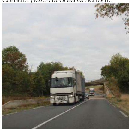
Glissière béton et pont ferroviaires peu qualifiant en entrée de site
