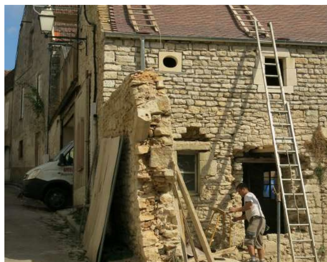
Le bâti traditionnel est un élément clé de la qualité du territoire du vézélien. Travaux de rénovation de bâtiments existants, en cours, dans le village de Vézelay.
