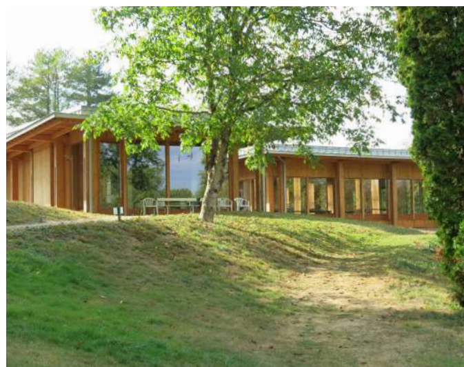
Centre d'Accueil et de Découvertes Archéologiques des Fontaines Salées. Architecte Jean-Paul Philippon, ADGP.
