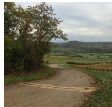
Chemin en enrobé générant des enjeux de gestion des eaux pluviales
