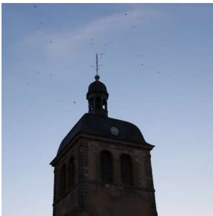
Intégration d'une antenne relais dans une pile de clocher
