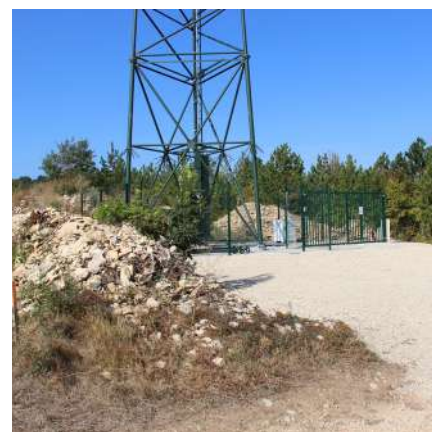
L'installation de l'antenne relais ne cherche pas l'intégration paysagère
