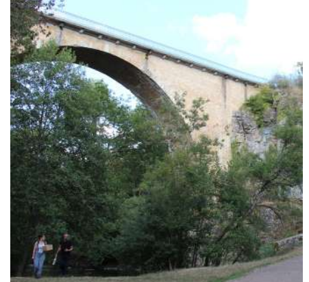
Utilisation d'un pont remarquable pour passer les réseaux électriques aériens
