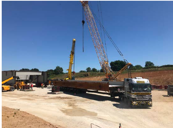
Livraison et mise en place des poutres sur la plateforme d'assemblage
