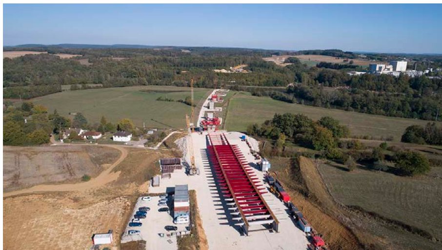
Premier tronçon du tablier assemblé
