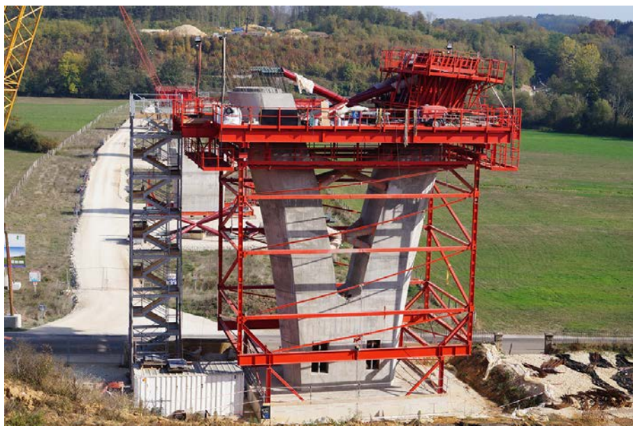
Pile P1 en voie d'achèvement
