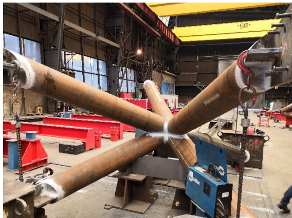
Croix en fabrication
