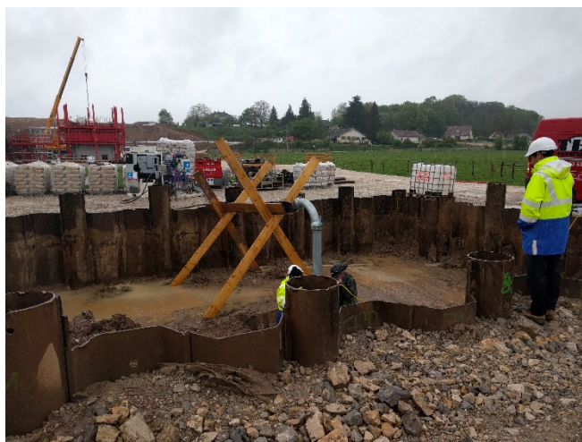
Opération de pompage dans un batardeau
