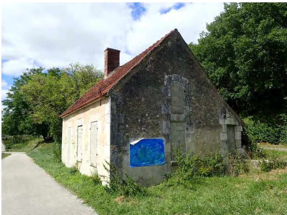
Maison éclusière au droit de la réserve naturelle (M. Jouve - CENB, 2018)
