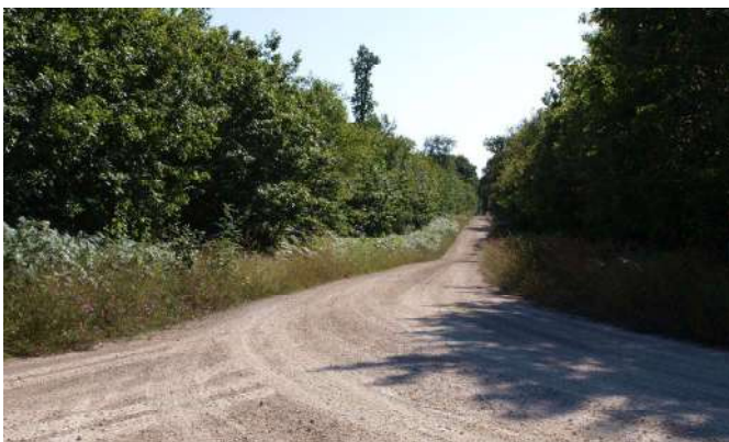
Piste forestière aux matériaux et abords de qualité cependant quelque peu large en termes d'emprise
