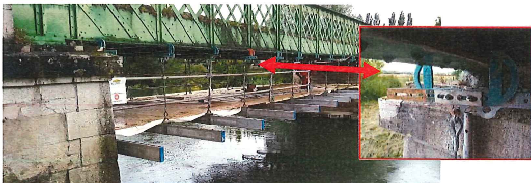
REALISATION DU MONTAGE DU PLATELAGE
