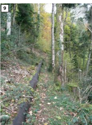
Implantation de la conduite forcée Secteur forestier
