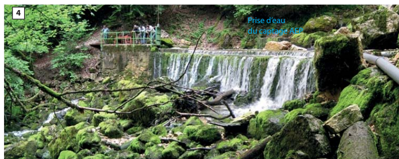
Vue du seuil et de la prise d'eau
