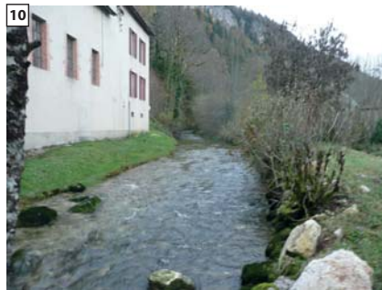
Bâtiment de la centrale, aval du TTC
