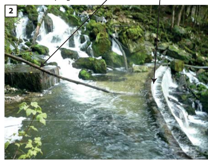
Retenue et captage AEP
