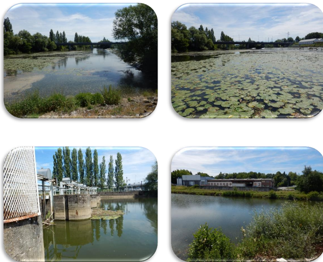
Fig. 26. Mosaïque de photographies du site industriel
