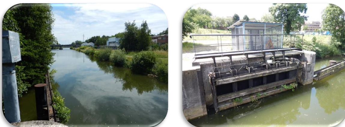
Fig. 28. CRR et porte de garde n°14 bis
