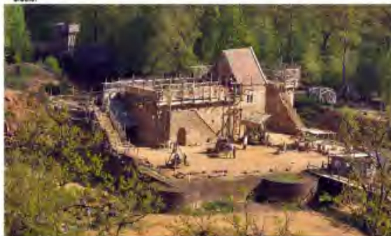
Le chantier dans la carrière - extrait du site officiel de Guédelon
