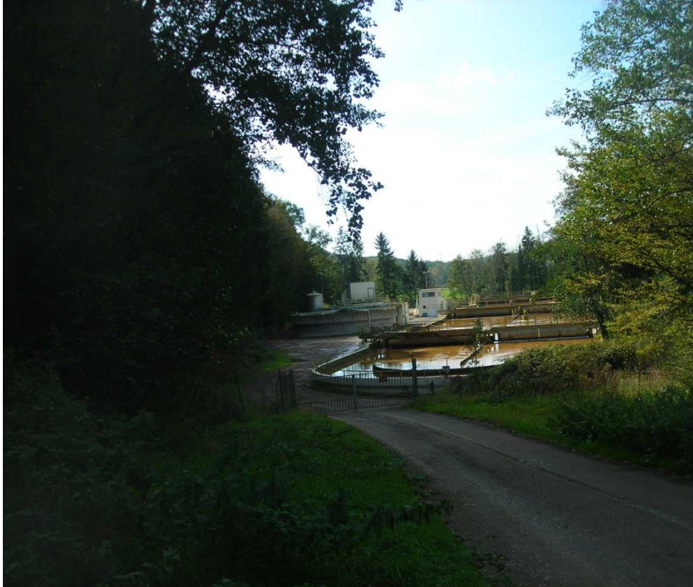
Figure 14 : Vue de la station EUROSERUM depuis la RD6
