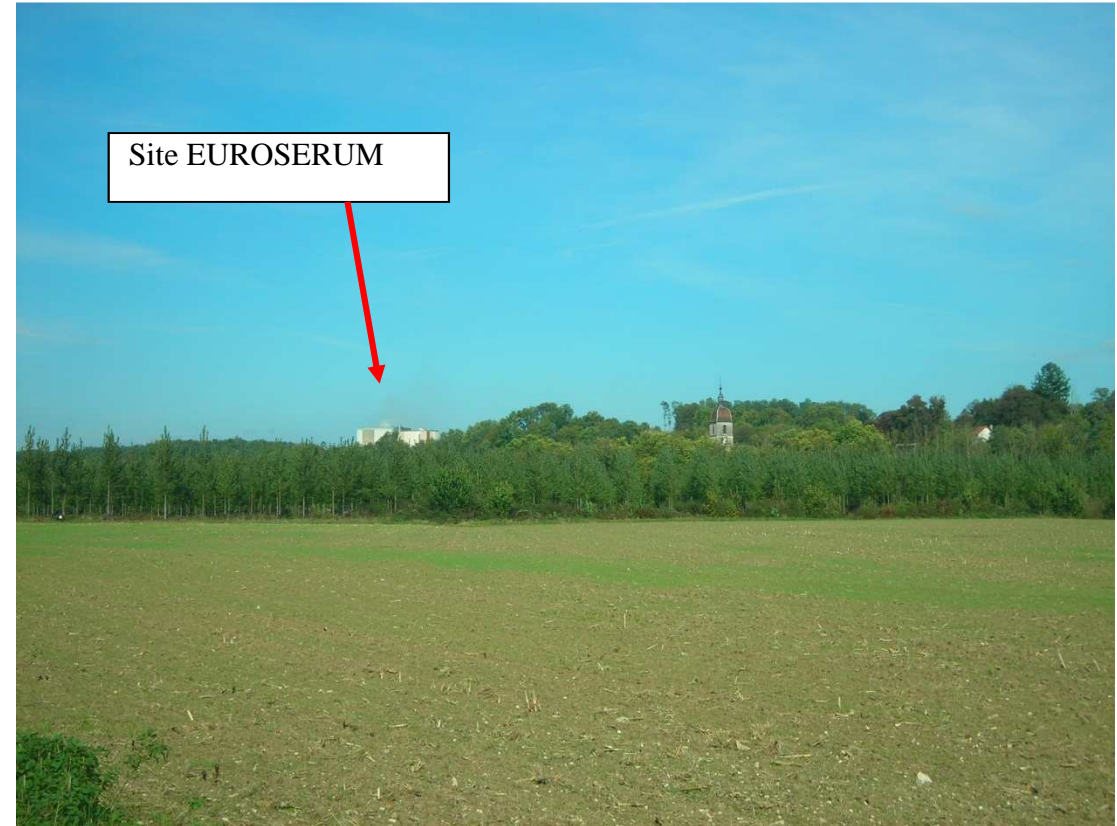
Figure 13 : Vue du clocher et de l'usine EUROSERUM depuis la rive droite, en aval de Port-sur-Saône
