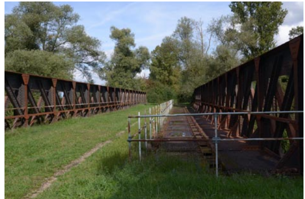
Chaussin, ouvrage sur l'Orain
