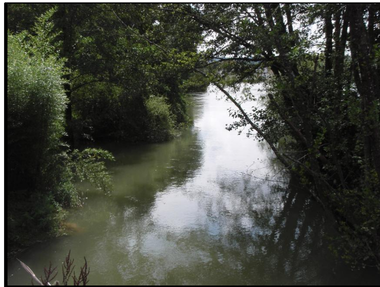
Photographie n° 7 : vue du début du canal d'aménée
