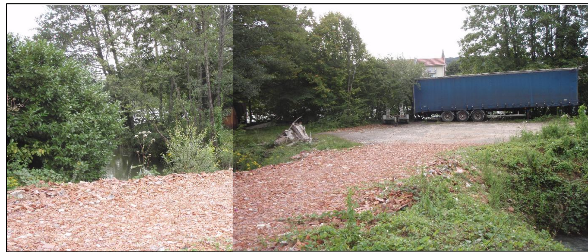
Photographie n° 8 : vue du canal d'aménée en rive droite du seuil et passage au-dessus de la 1ère conduite souterraine
