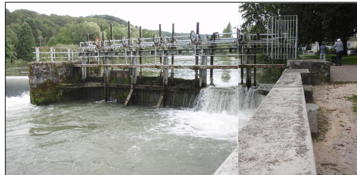
Photographie n° 4 : vue aval des vannes de décharge en rive gauche du seuil de prise d'eau
