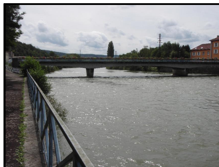
Photographie n° 22 : vue aval du tronçon court-circuité
