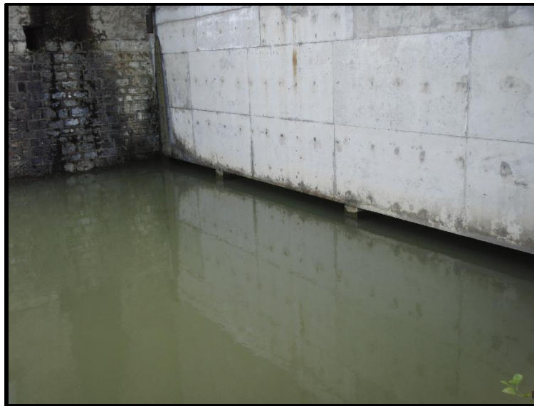
Photographie n° 18 : vue de la sortie des eaux turbinées
