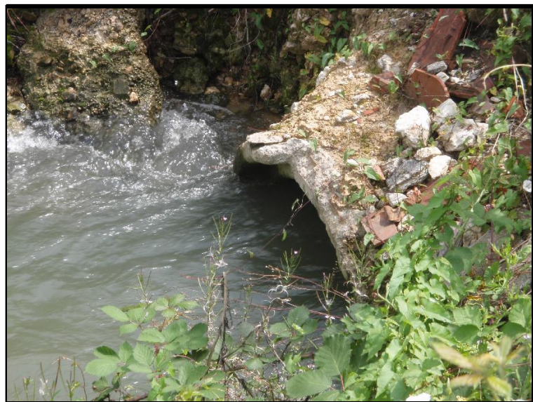
Photographie n° 9 : vue amont de la 1ère conduite souterraine
