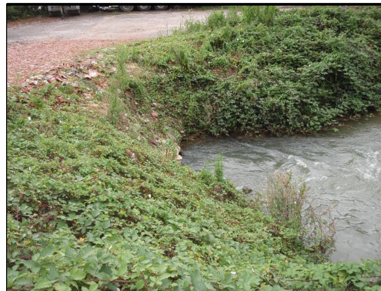
Photographie n° 10 : vue aval de la 1ère conduite souterraine
