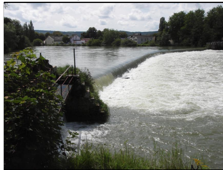
Photographie n° 1 : vue du seuil de prise d'eau, depuis la rive droite, et de ses vannages de décharge en rive droite et gauche
