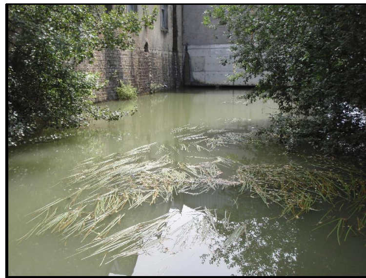
Photographie n° 19 : vue du canal de fuite
