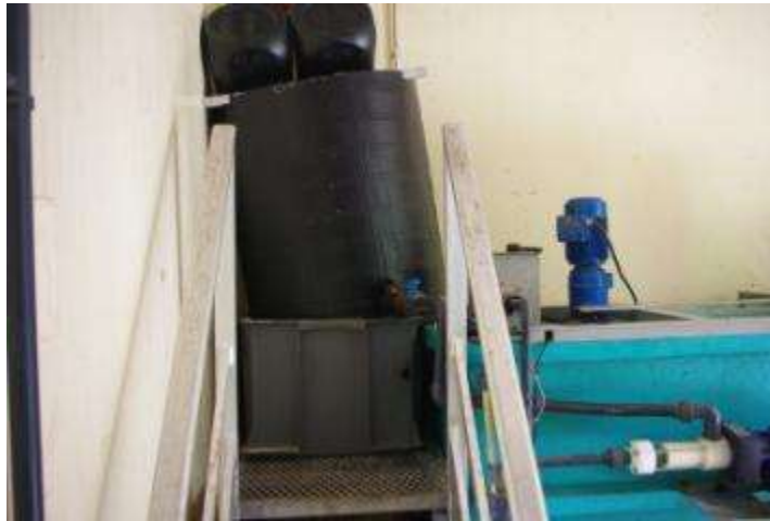
Fig. 29. Dispositif de remplissage de bac à polymère
