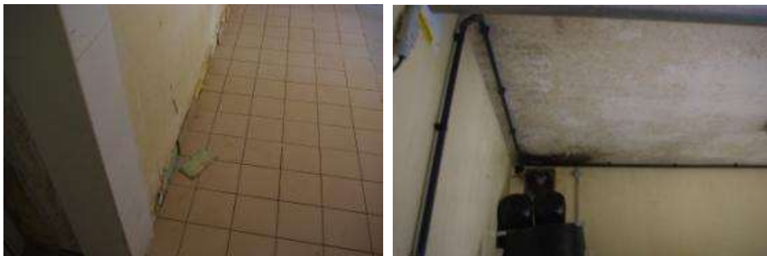
Fig. 28. Conséquences de l'humidité
