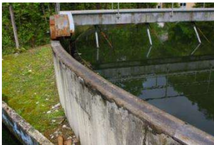
Fig. 24. Chemin de roulement
