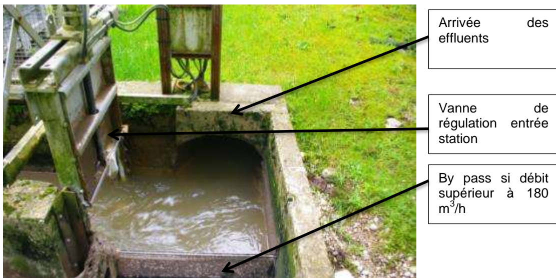
Fig. 15. Répartition débit entrée station
