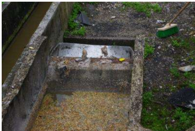
Fig. 20. Exutoire des graisses
