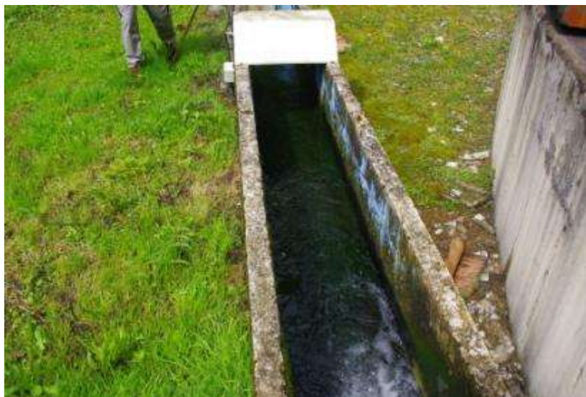
Fig. 25. Canal de rejet
