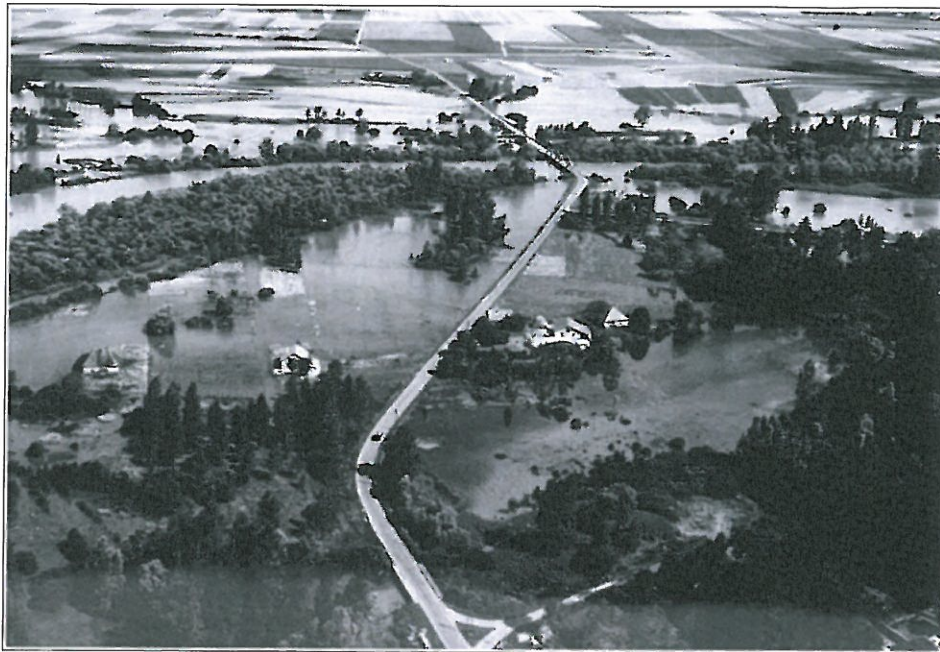
Photo aérienne de décembre 1966 – crue de la Loue – source : DDE39 – service hydraulique la route départementale n°53 est visible au centre du cliché les habitations du petit hameau sont anciennes et sensibles aux inondations la morte des fontaines est visible en haut à gauche
