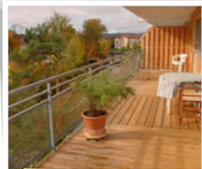
Garde-corps d'une hauteur < 1,00 m suite ajout plancher
