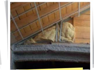
Isolant mal positionné
