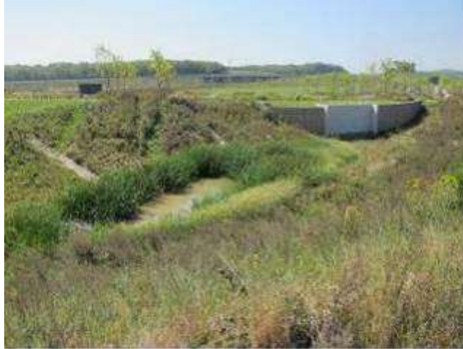
Exemple de bassins de récupération des eaux pluviales adaptés au développement de la faune :Le Bassin de la gare LGV (Méroux) accueille des Grenouilles vertes, l'avifaune y est diversifiée
