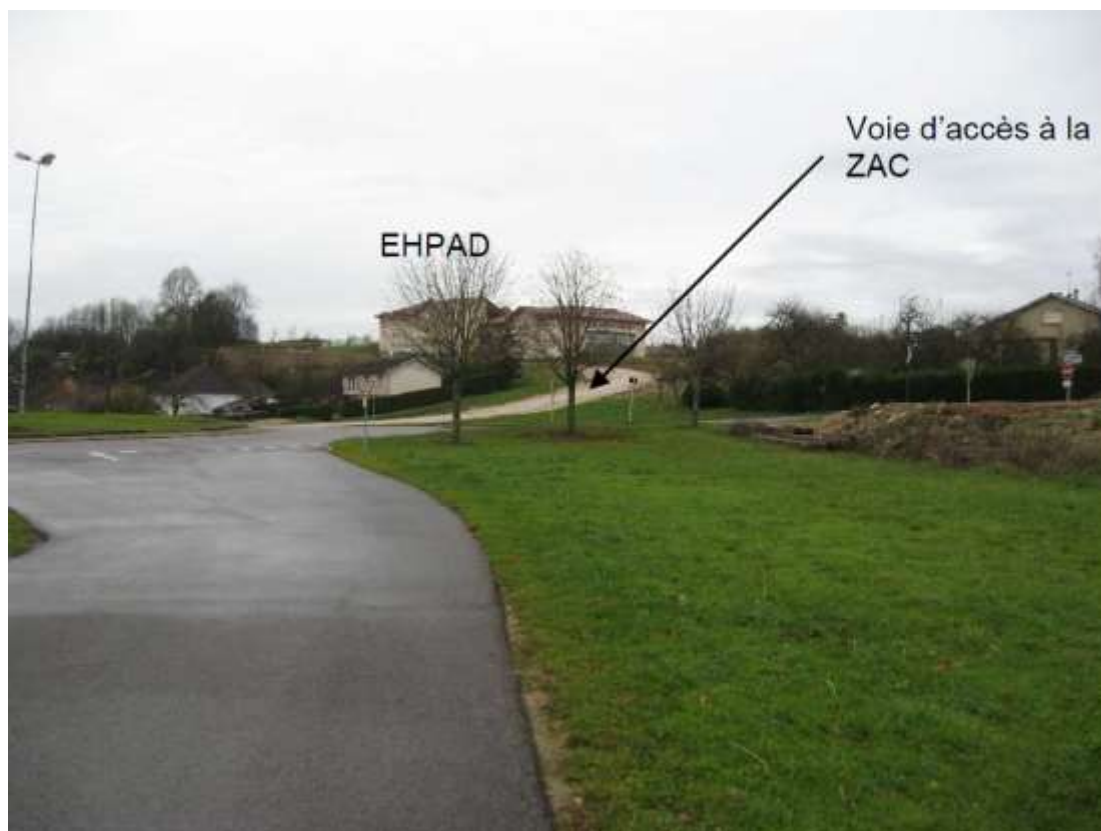
Figure 3 voie d'accès à l'EHPAD et à la ZAC
