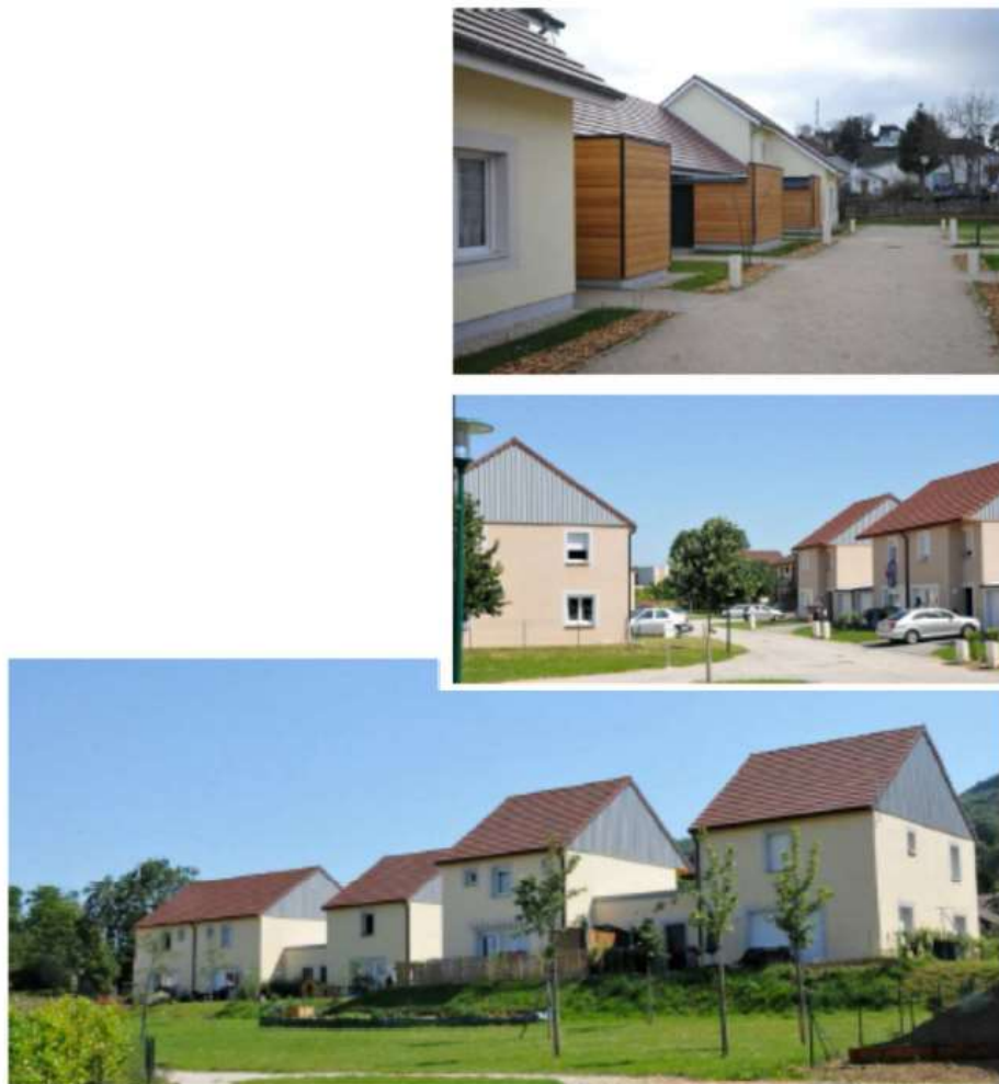
Figure 19 exemple de voiries
