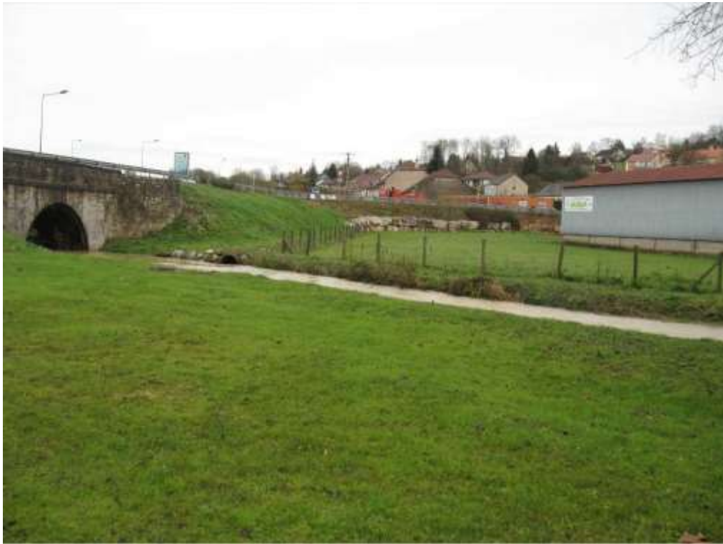
Figure 20 ouvrage de franchissement actuel de la Vèze par la RD 673
