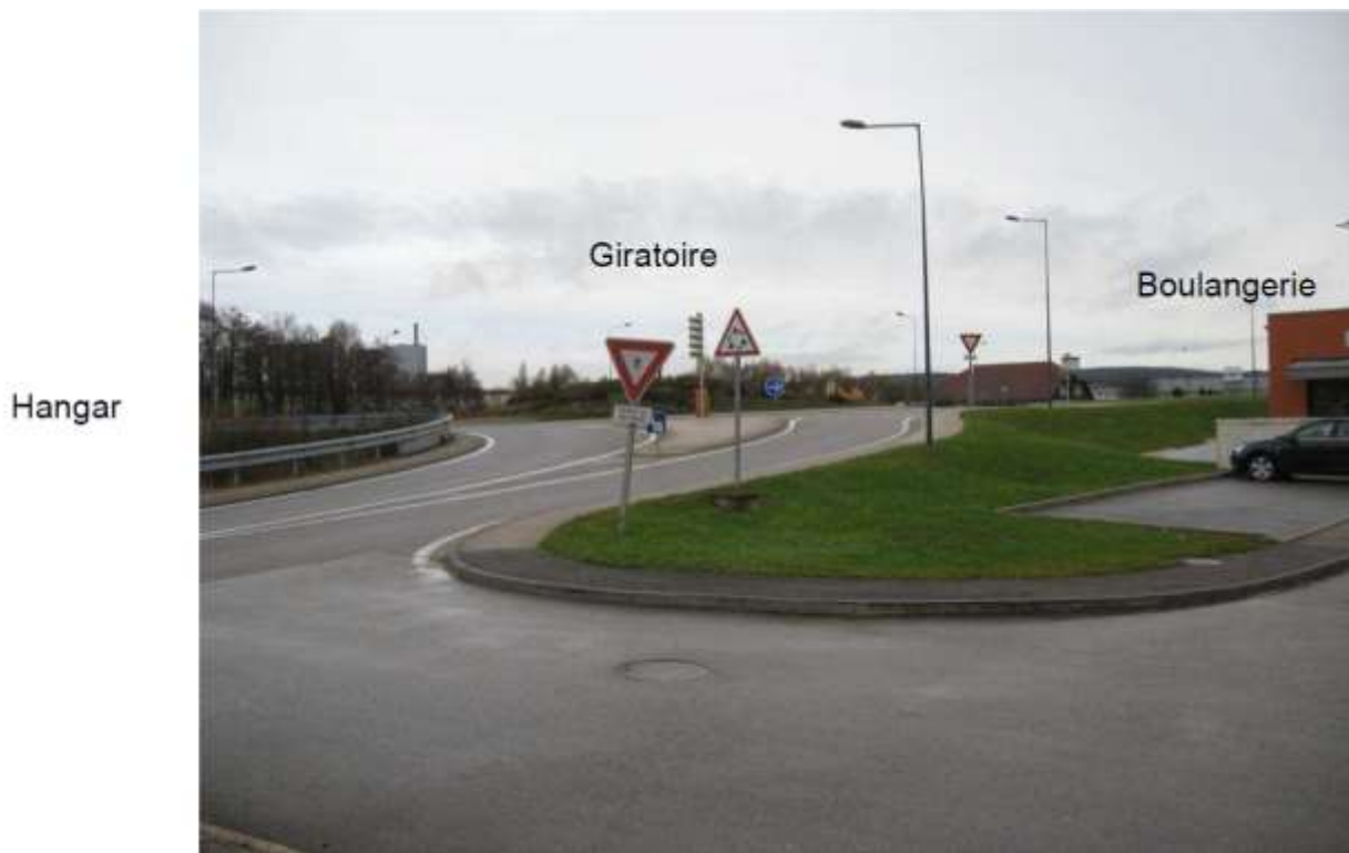
Figure 16 carrefour giratoire à l'entrée de Rochefort-sur-Nenon
