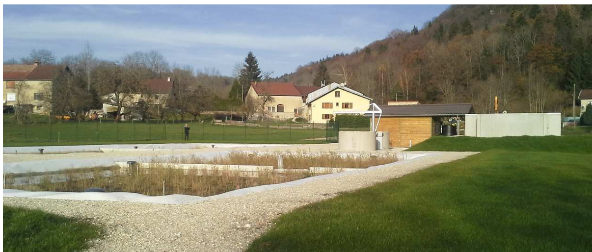
Photographie 1 : vue générale de la station (IRH)
