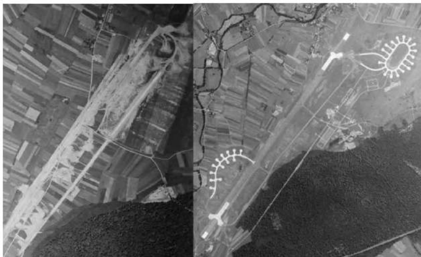
Travaux de terrassement 1950
