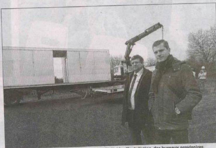
■ Serge Pflumio, le président de Car2Road surveillait, hier l'installation des bureaux provisoires.
