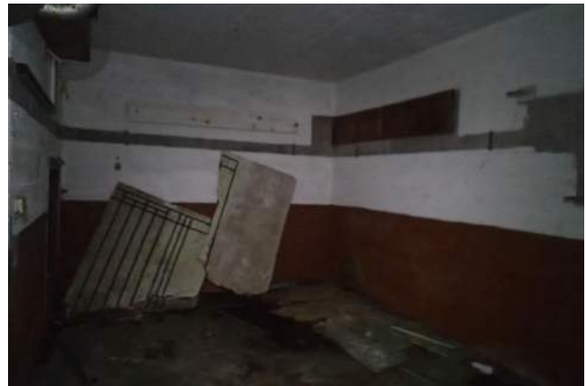
Vue de l'intérieur d'un bunker (aucune trace d'utilisation)
