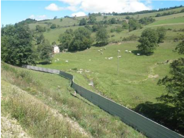
Exemple de clôture en « dur » Source : ECOTER, 2014
