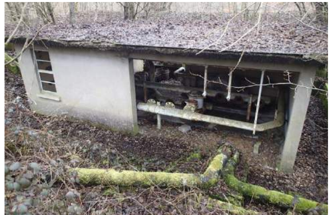
Vue d'un bâtiment dédié à la gestion du carburant (aucune trace d'utilisation)
