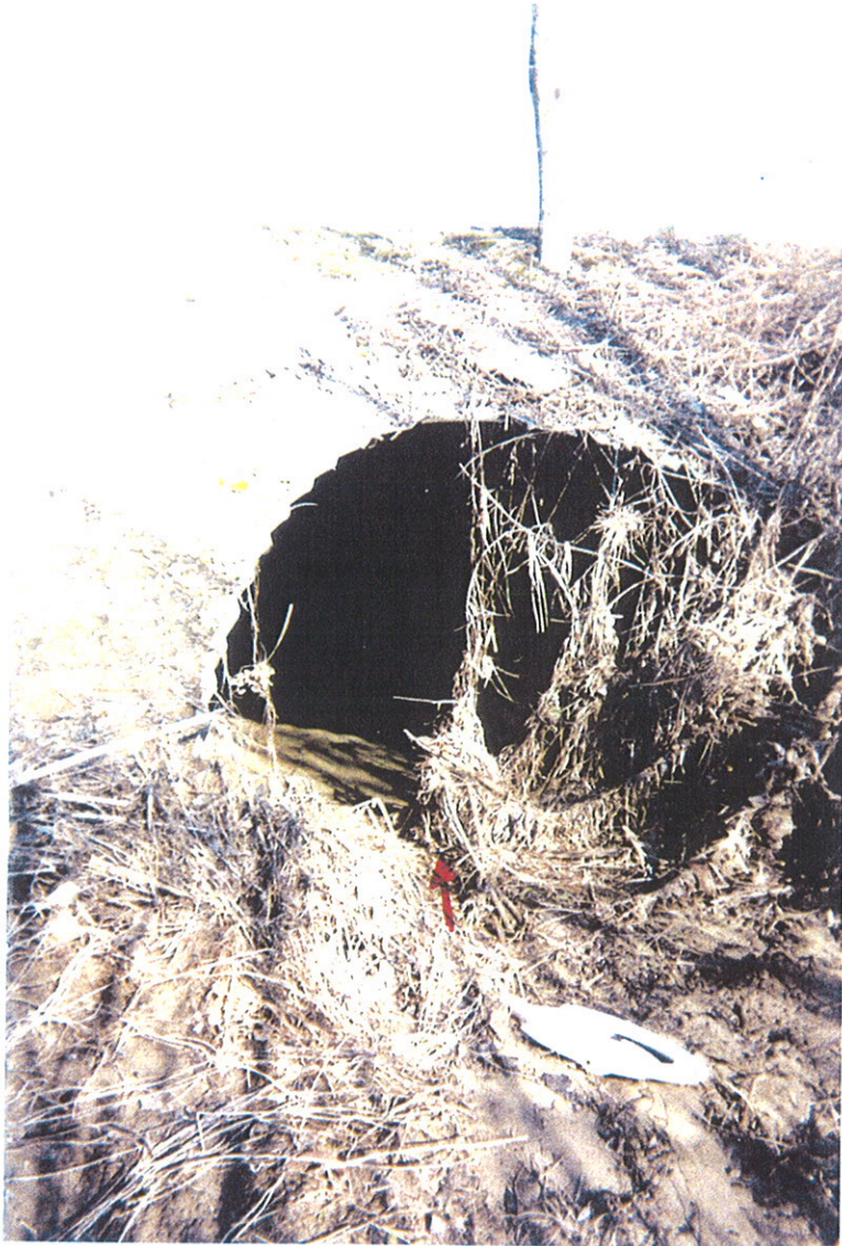
Photo 5 : Vue amont de la buse arche métallique de décharge.
