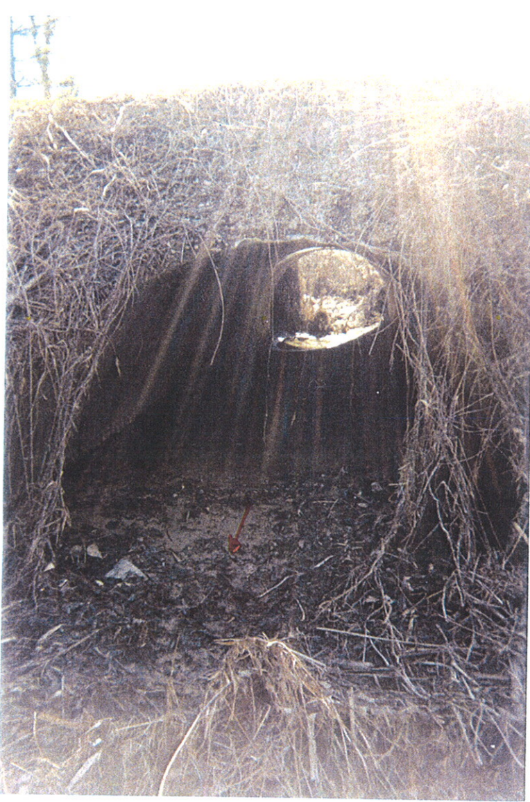
Photo 7 : Vue aval de la buse arche métallique de décharge.
