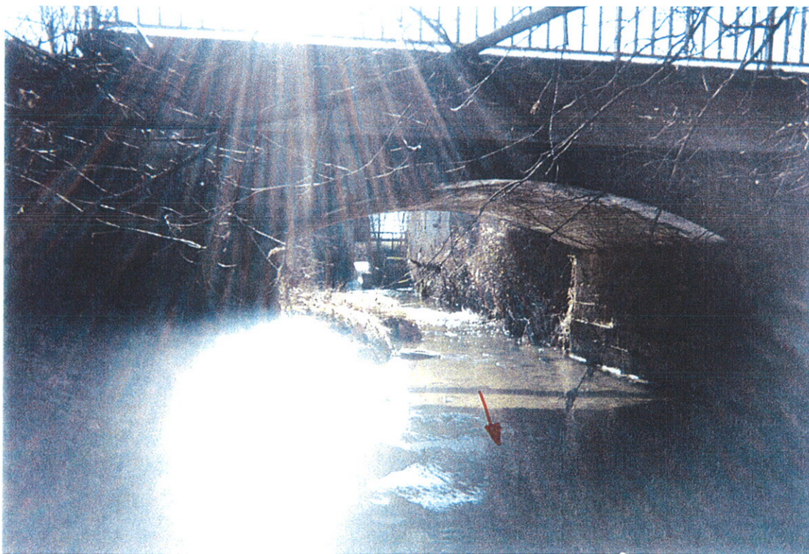
Photo 6 : Vue aval du pont voûte sur le Besançon.
