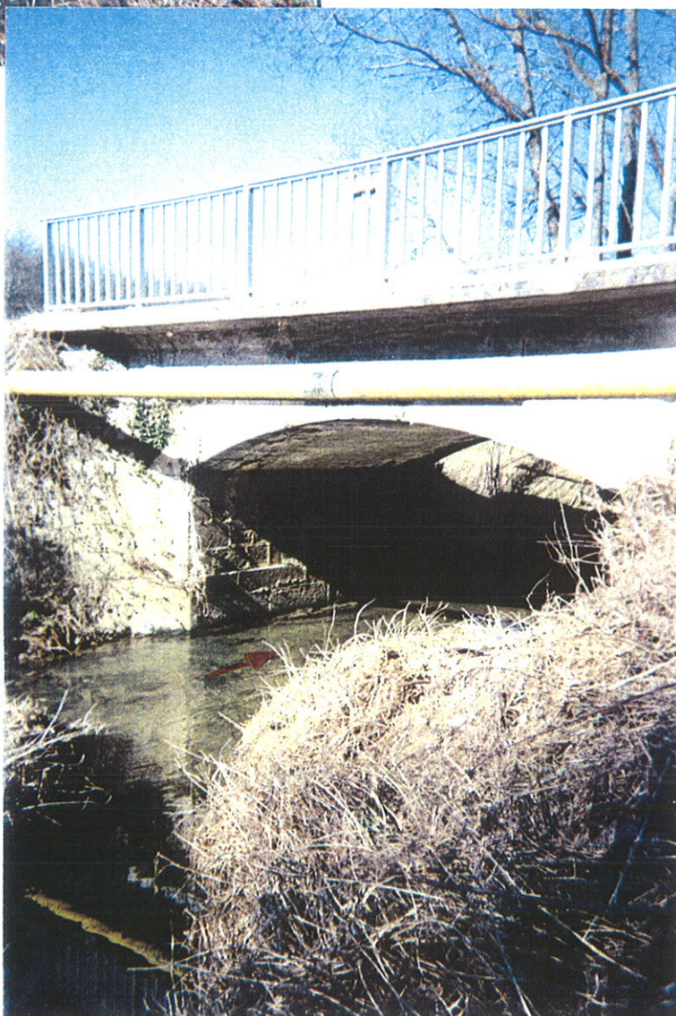
Photo 4 : le pont voûte de la RD 3 sur le Besançon.
