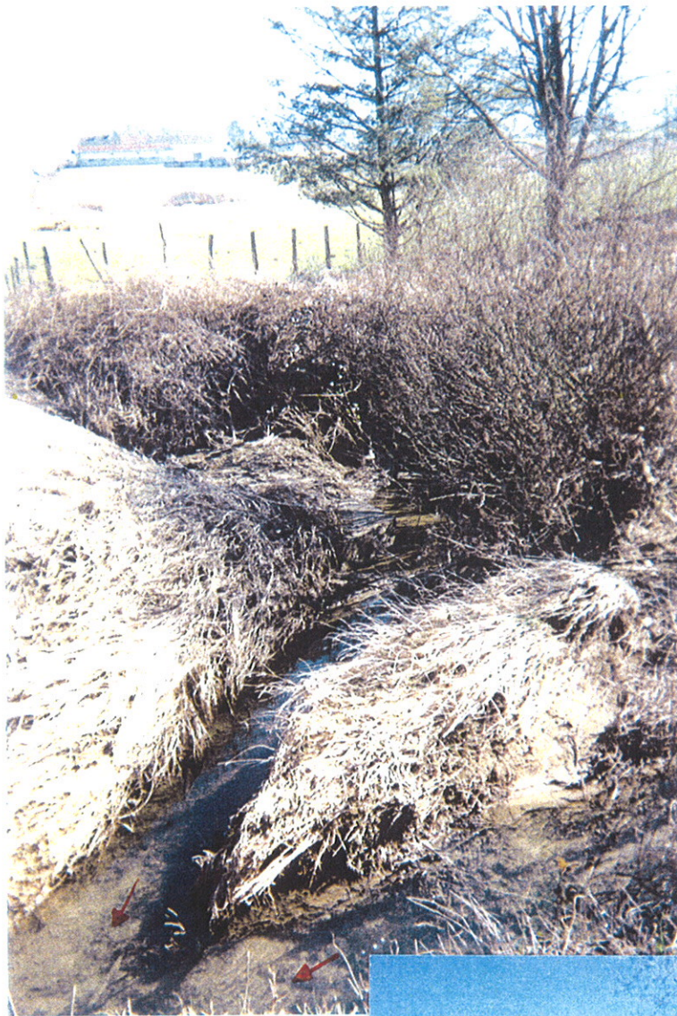
Photo 3 : Entonnement du Besançon sous la RD 3.
