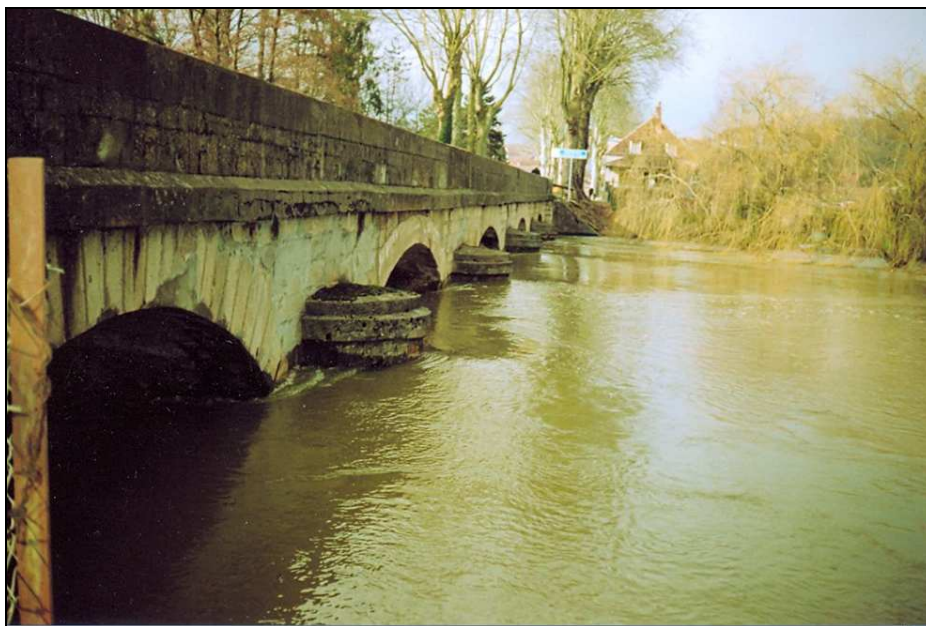
Photo 8 : Vue du pont routier sur l'OGNON
