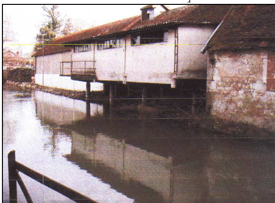
Photo 3 : Vue du canal d'amenée depuis l'aval
