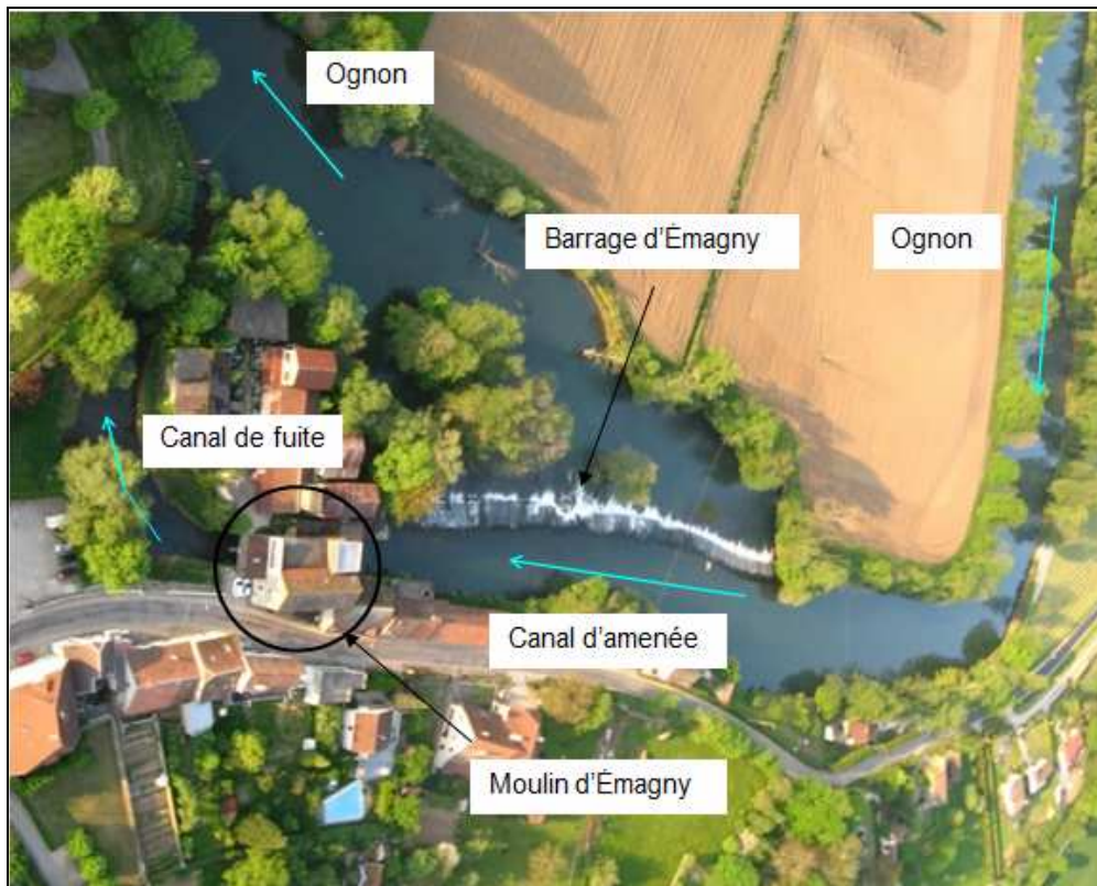
Photo 7 : Vue du moulin et du barrage d'ÉMAGNY
