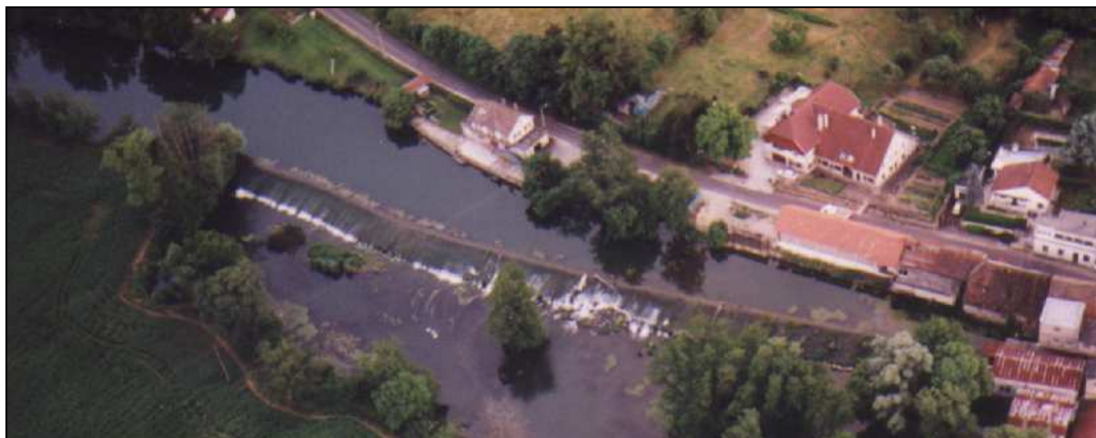
Photo 2 : Vue aérienne du barrage
