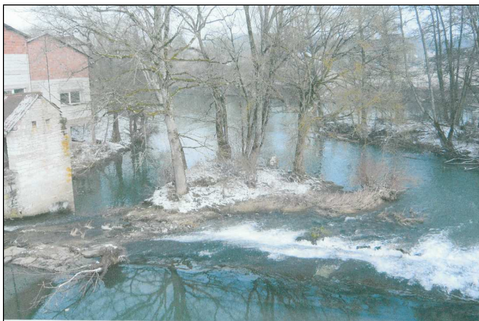
Photo 5 : Vue de la zone d'implantation dans l'état actuel
