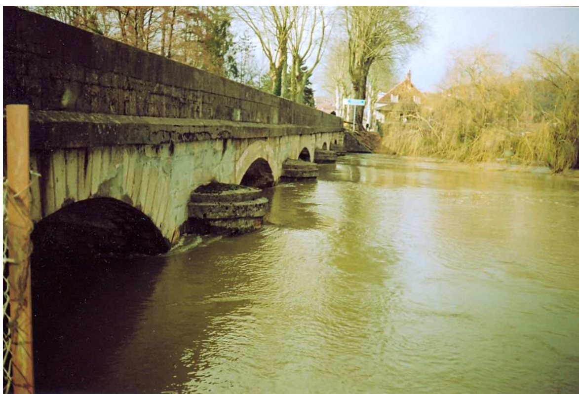
Figure 4 : Pont routier sur l'Ognon
