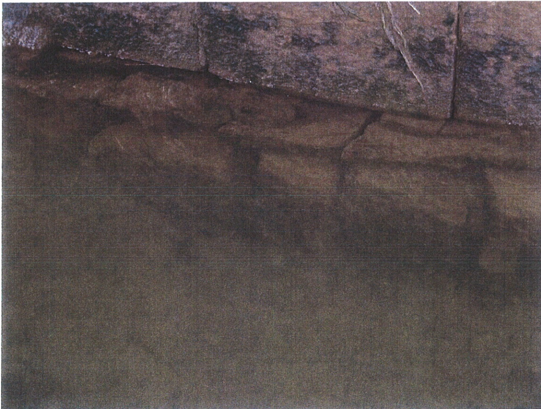
Ph.19 et 20 Disjointoiement profond en pied de piédroit R.G. côté aval et extrusion de moellons
