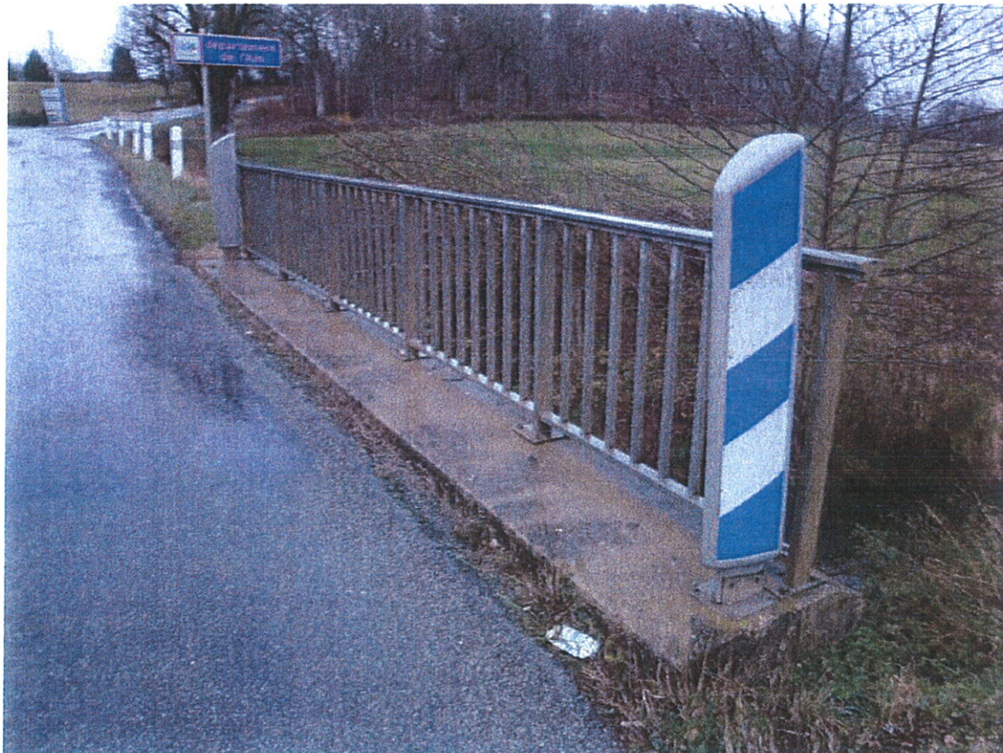
Ph. 36 Trottoir et garde corps aval
