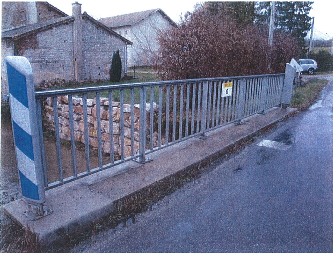
Ph.35 Trottoir et garde corps amont
