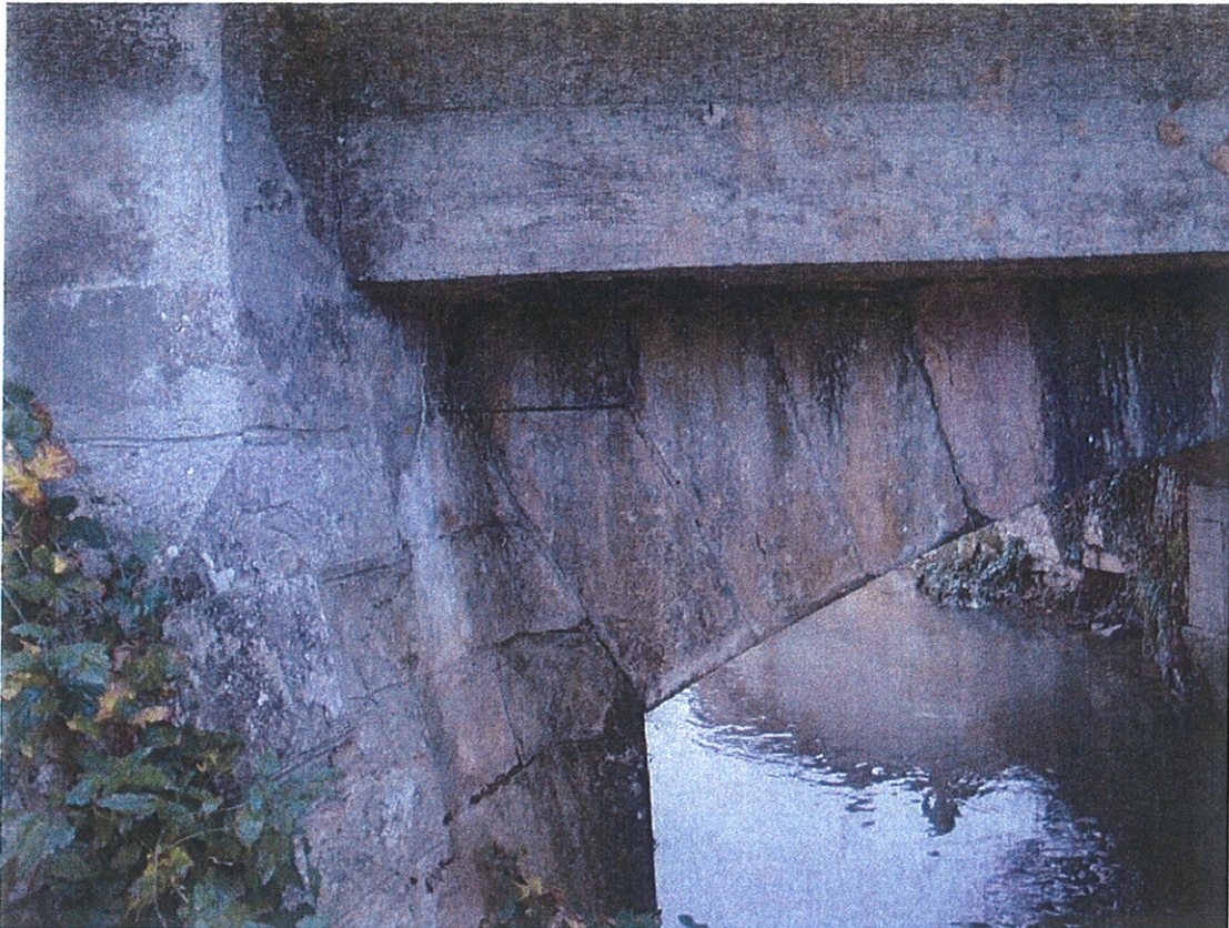
Ph.25 Pierre de bandeau aval R.D. légèrement extrudée
