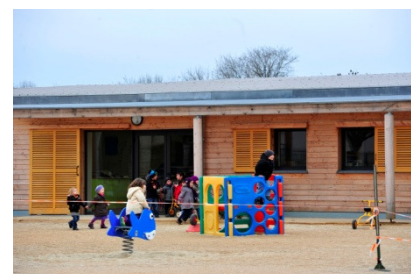
Pôle scolaire de Sainte-Colombe
