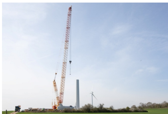
Chantier éolien à Beurey-Bauguay, crédit photo : Pierre COMBIER
