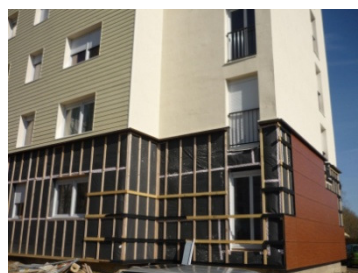
Chantier de rénovation BBC de 102 logements sociaux à Autun
