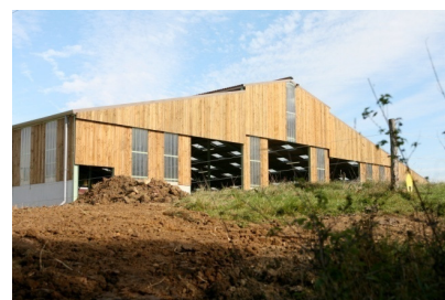
Bâtiment agricole en bois à Palinges, Crédit photo : Pierre COMBIER
