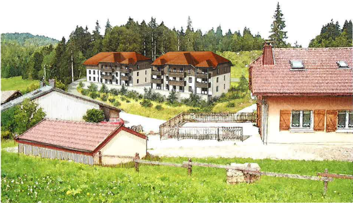
Vue depuis lotissement LA SAMBINE sur secteur bas du lotissement (COLLECTIF A)
