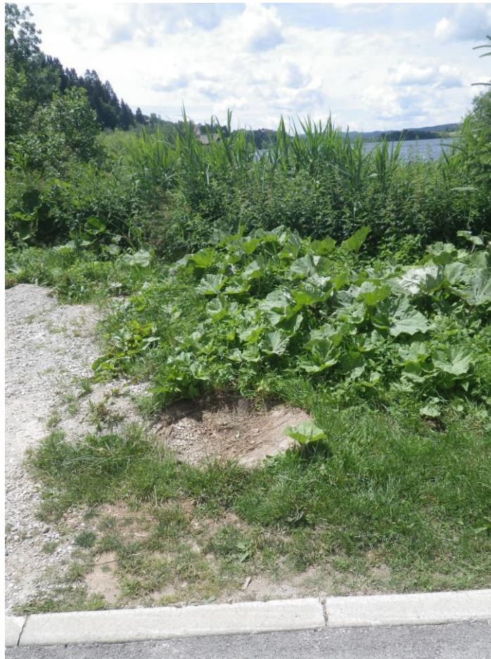
Tampon du premier poste de refoulement
