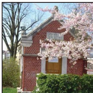
Figure 3 : Station de mesure de Belfort Octroi
