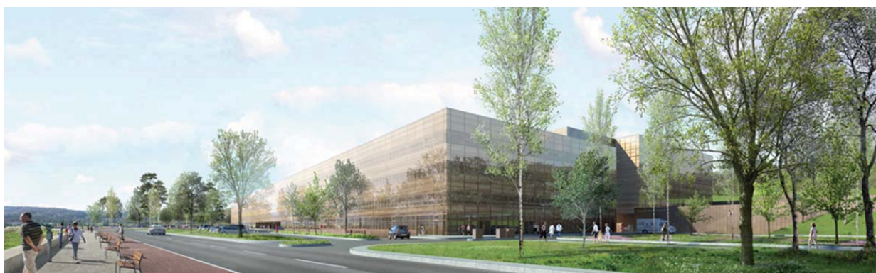
Figure 91 : Vue panoramique de l'hôpital médian
