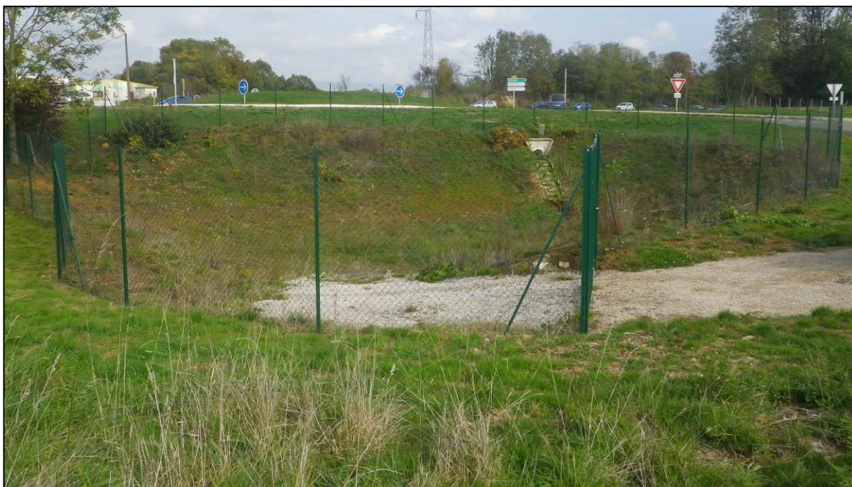
Bassin d'infiltration giratoire de la RD 673.
