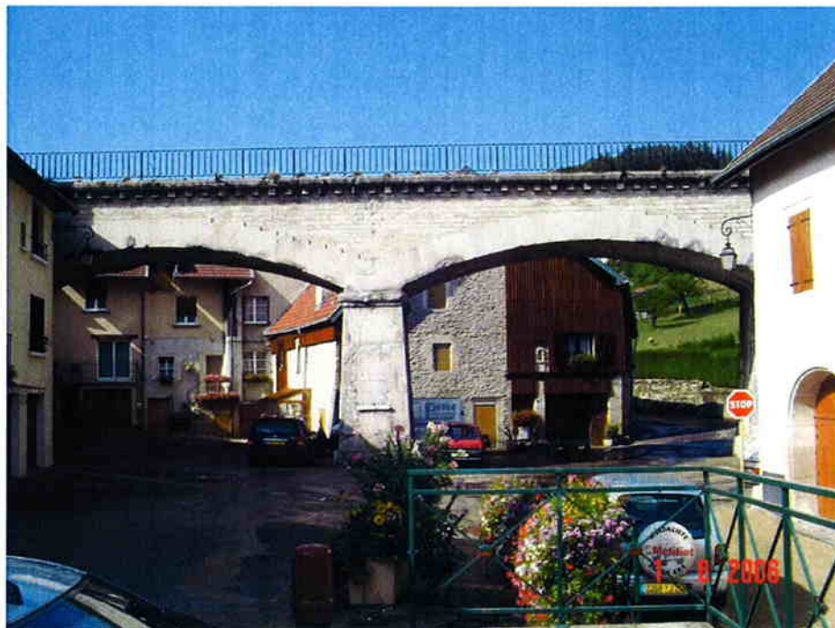
Photo 8 : zone 5 (profils 14 à 18) - espaces verts dans le prolongement du viaduc puis rue de la Plante.
