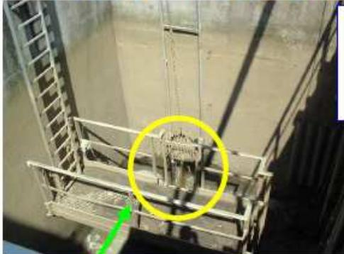
Poste de prélèvement autosurveillance à l'entrée de la station. Des analyses sont effectuées régulièrement.
