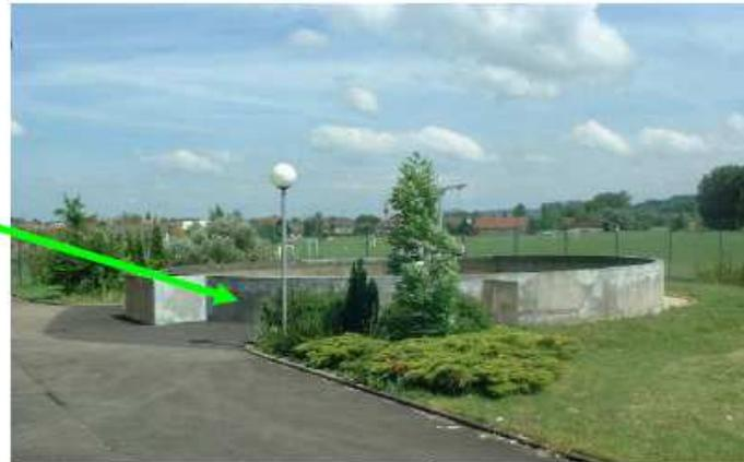
Aire de stockage des boues d'une capacité d'environ 700 tonnes soit 5 mois de stockage
