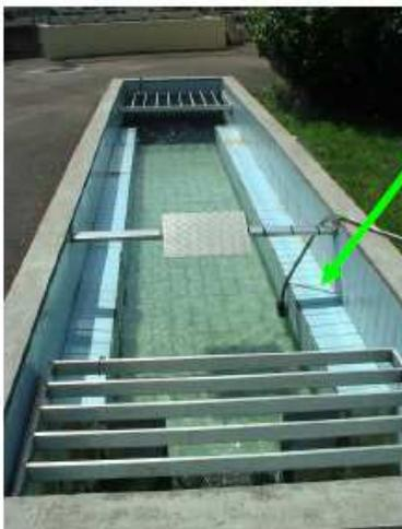
L'eau épurée passe pour terminer, par le canal de rejet avant de rejoindre la rivière. Toute cette station est pilotée par plusieurs automates de gestion équipés d'une succession de systèmes de contrôle qui permettent de suivre son bon fonctionnement 24 h sur 24. L'exploitation de la station d'épuration est confiée à un gérant privé.
