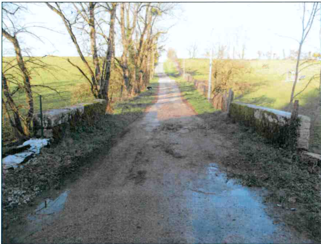
Photo 1 : Vue ouvrage depuis la rive gauche (17/01/2014)
