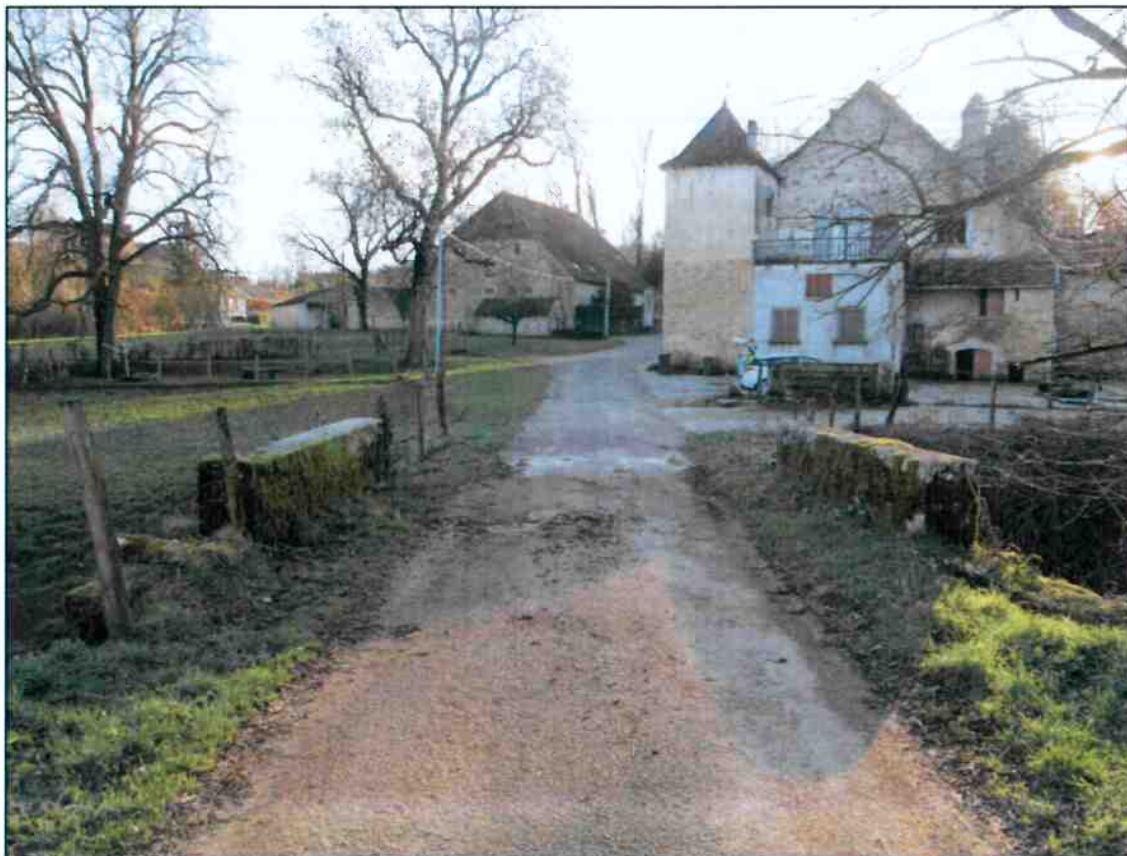
Photo 2 : Vue ouvrage depuis la rive droite (17/01/2014)
