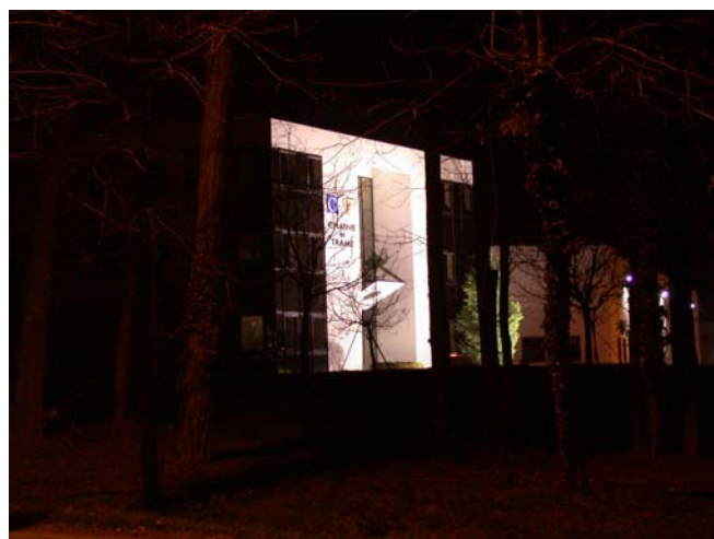
Les projecteurs encastrés au sol éclairent ces façades sans créer de nuisances visuelles. Toutefois les projecteurs mal réglés envoient inutilement de la lumière vers le ciel (gaspillage d'énergie, pollution lumineuse du ciel).
