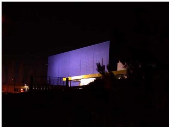
Les projecteurs encastrés au sol assurent une bonne mise en valeur de ces façades. Dans ce cas, les projecteurs ne sont pas suffisamment bien cadrés, et une partie du flux lumineux se perd dans le ciel.
