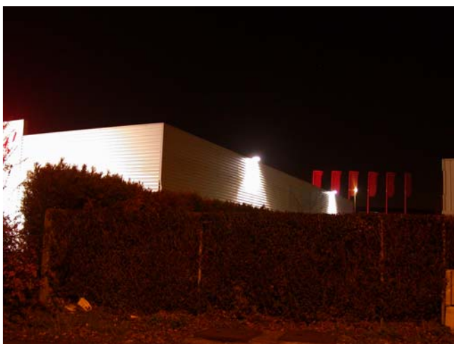
Les projecteurs installés sur cette façade sont bien réglés. Ils éclairent le sol en périphérie du bâtiment sans créer de nuisances visuelles.
