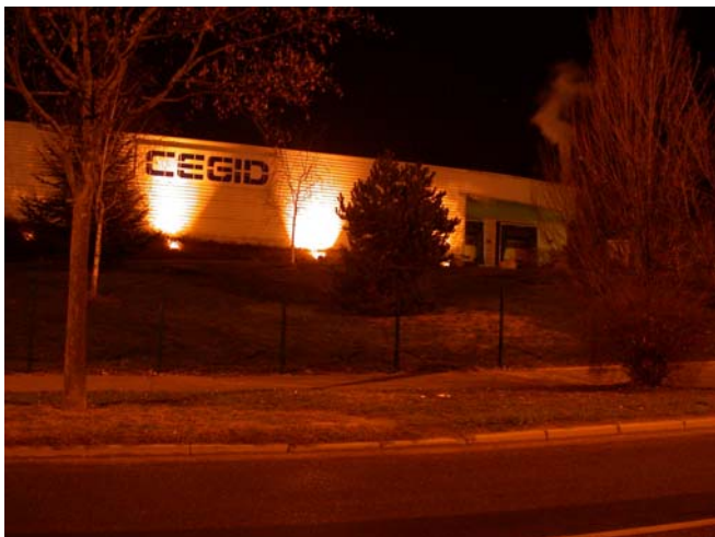
Les projecteurs encastrés au sol n'ont pas la photométrie qui leur permettrait d'éclairer de manière homogène cette façade.
