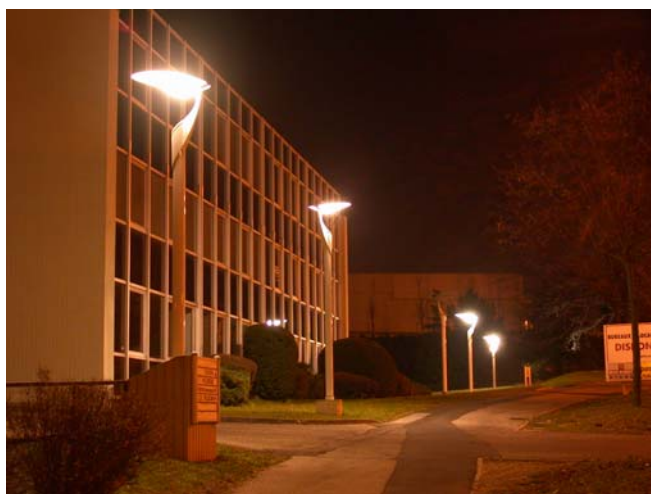
Les luminaires à éclairage indirect assurent un éclairage efficace et de qualité aux abords de ce bâtiment.
