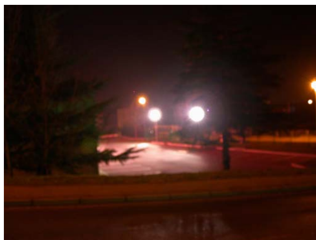
Les projecteurs installés sur mâts pour éclairer la façade du bâtiment provoquent des nuisances visuelles pour les usagers de la route qui borde ce bâtiment. Leurs flux mal contrôlés éclairent aussi bien le sol, le ciel que la façade.
