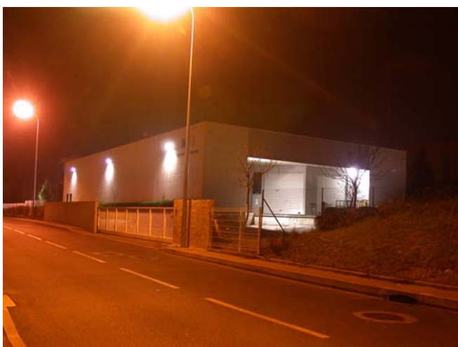
Les projecteurs installés sur cette façade projettent leurs flux vers l'extérieur et créent des éblouissements d'inconfort et des nuisances visuelles, notamment pour les usagers de la route.
