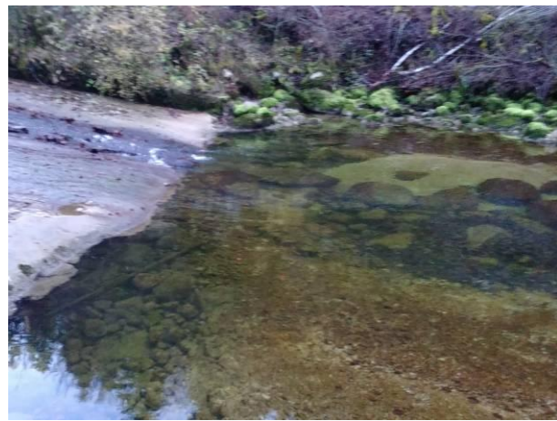
Vue de la fosse au pied de l'ouvrage
