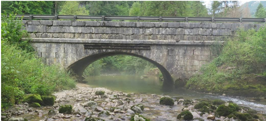
Vue de l'ouvrage
