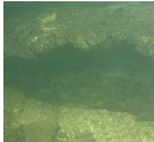
Vue de la culée rive droite
