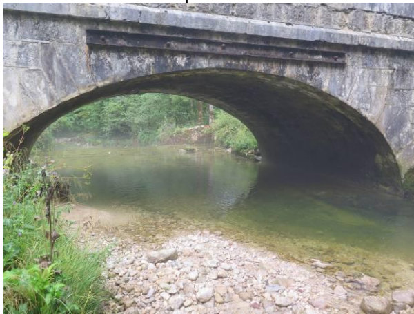
Vue du lit sous le pont
