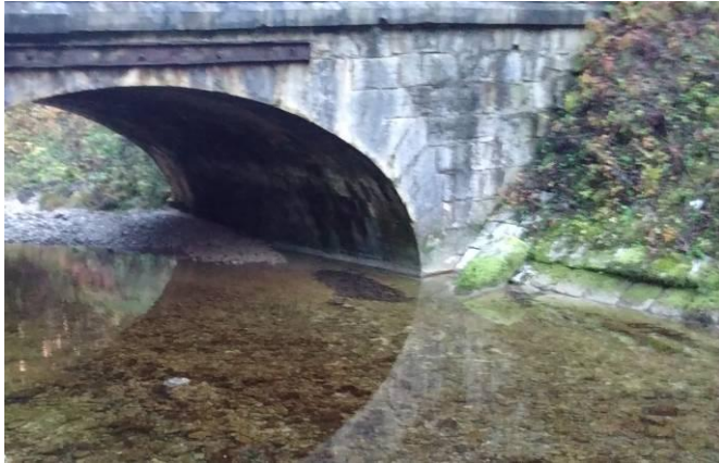
Vue du parement aval rive gauche.
