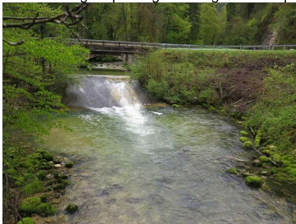
Vue à l'aval
