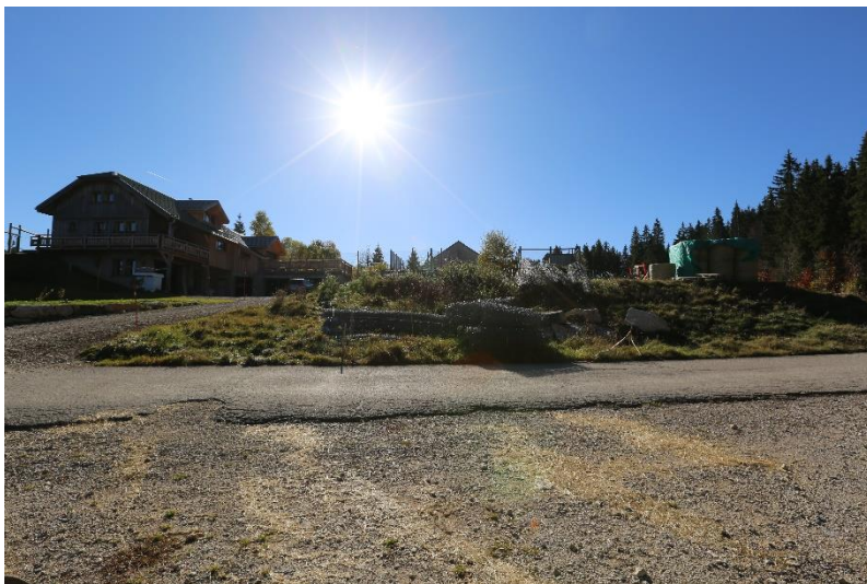
Vue Nord emplacement bâtiment technique depuis loge quarantaine
