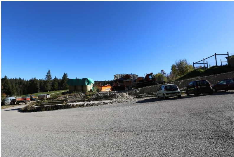
Vue Ouest emplacement bâtiment technique depuis parking visiteurs
