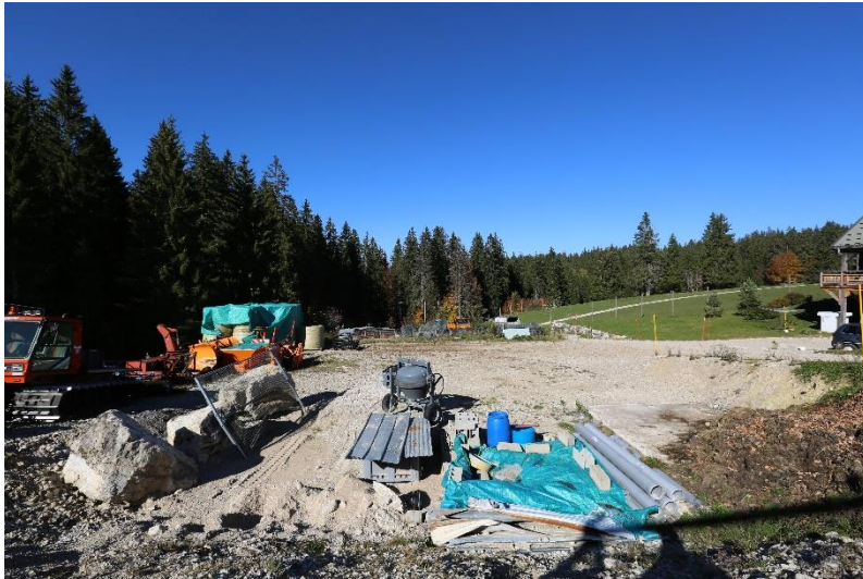
Vue Sud emplacement bâtiment technique depuis loge quarantaine
