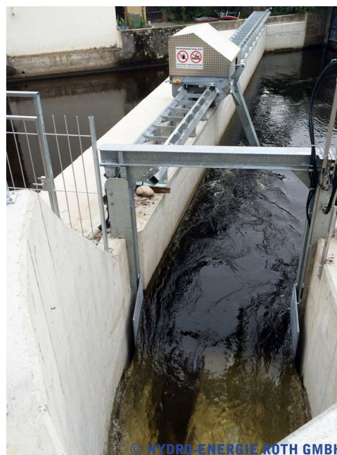
Illustration 6: photo lors d'un cycle de nettoyage (trajet retour) Source :Hydro-Energie Roth GmbH
