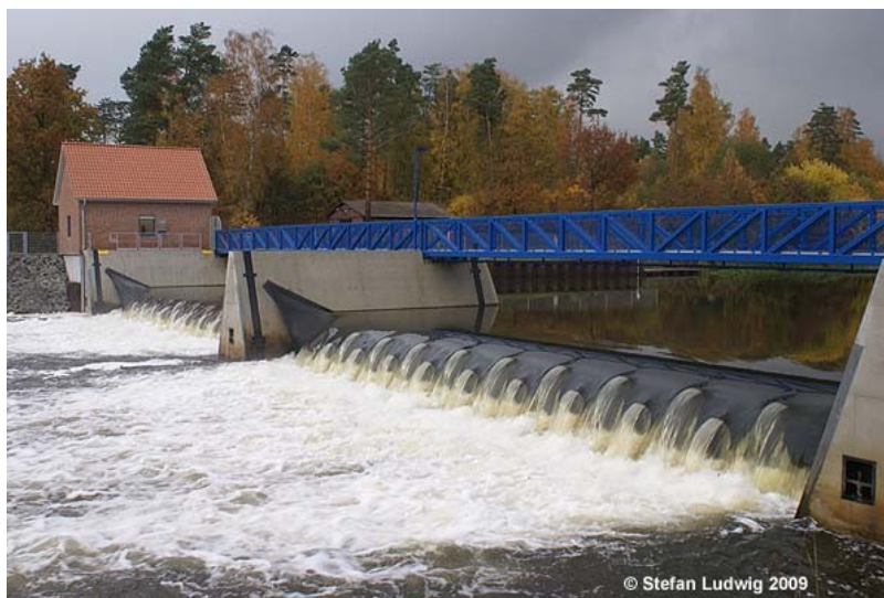
Illustration 8: exemple d'un barrage gonflable source : Stefan Ludwig
