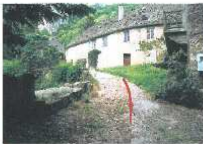
7 accès depuis la rue de la Seille, en bon état
