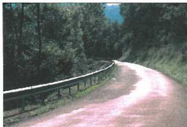
Remplacement des glissières métalliques
