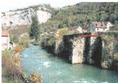
2 au bord du mur de soutènement
