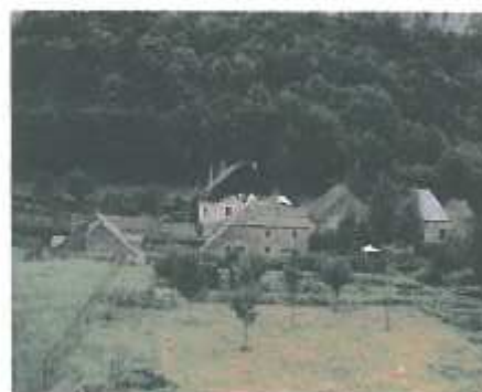
toiture en laves
