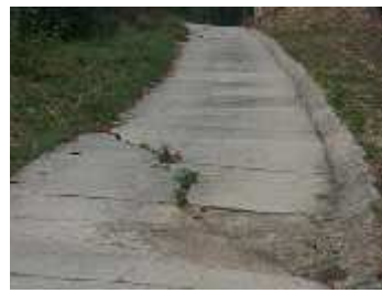
La collecte des eaux de ruissellement se fait par trois procédés : les canalisations de béton en bord de route, les fossés enherbés, les chemins d'exploitation avec pente et contre-pente.
