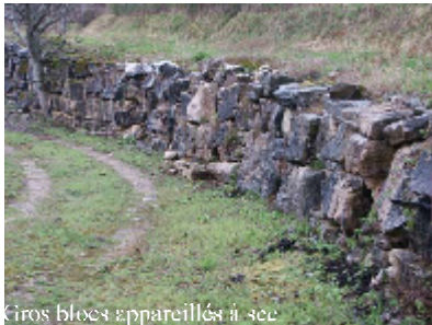
Gros blocs appareillés à sec
