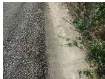
La collecte des eaux de ruissellement se fait par trois procédés : les canalisations de béton en bord de route, les fossés enherbés, les chemins d'exploitation avec pente et contre-pente.
