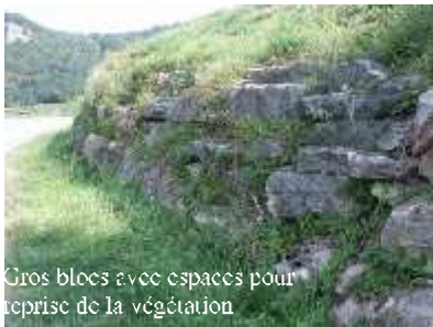
Gros blocs appareillés à sec
