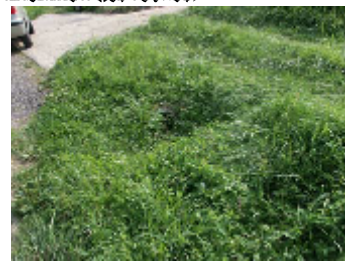
La collecte des eaux de ruissellement se fait par trois procédés : les canalisations de béton en bord de route, les fossés enherbés, les chemins d'exploitation avec pente et contre-pente.
