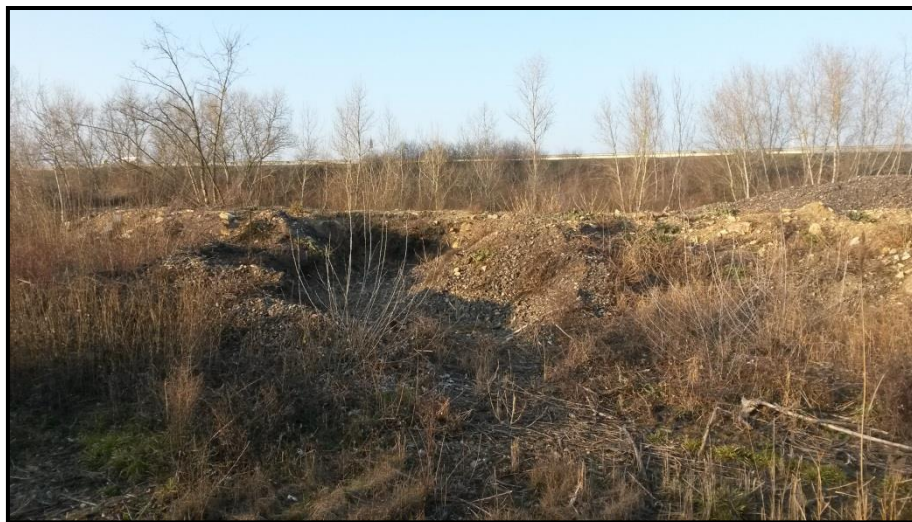
Figure 25 : Remblais – Source : ©Egis, 2017
