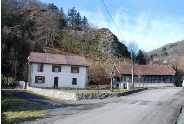
Constructions sous falaise à Auxelles-Haut (90) (photo BRGM).
