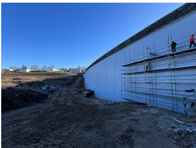
La géomembrane d'étanchéité en cours de pose
