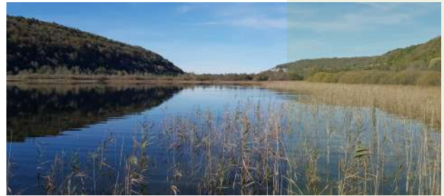
Chantier de restauration du Lac de Chambly (39)
