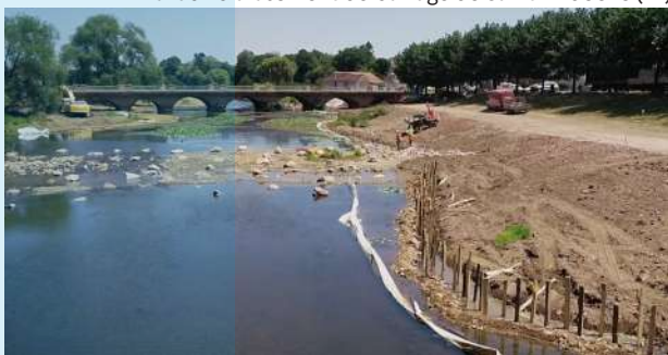
Travaux d'arasement du barrage de Saint-Andoche (71)
