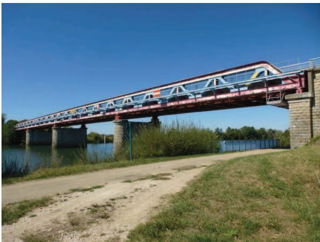
Figure 3 : Vue de l'élévation aval de l'ouvrage concerné (Source : CD 21)
