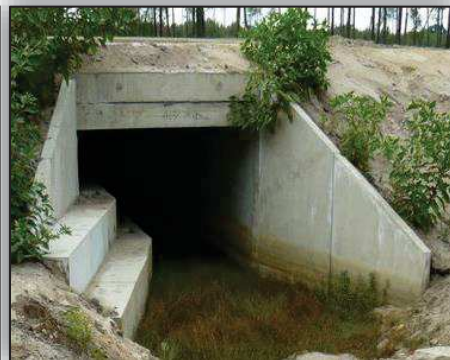
Exemple de passage à faune mixte avec des banquettes (source SETS et DREAL Aquitaine - 2010)
