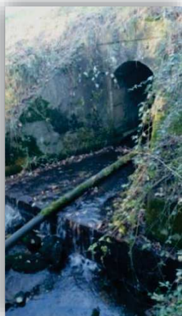
Figure 40 : Ruisseau de Balaine au Point 9. Il est préférable d'éviter la présence de seuil ou de chute afin de ne pas créer une rupture de continuité.
